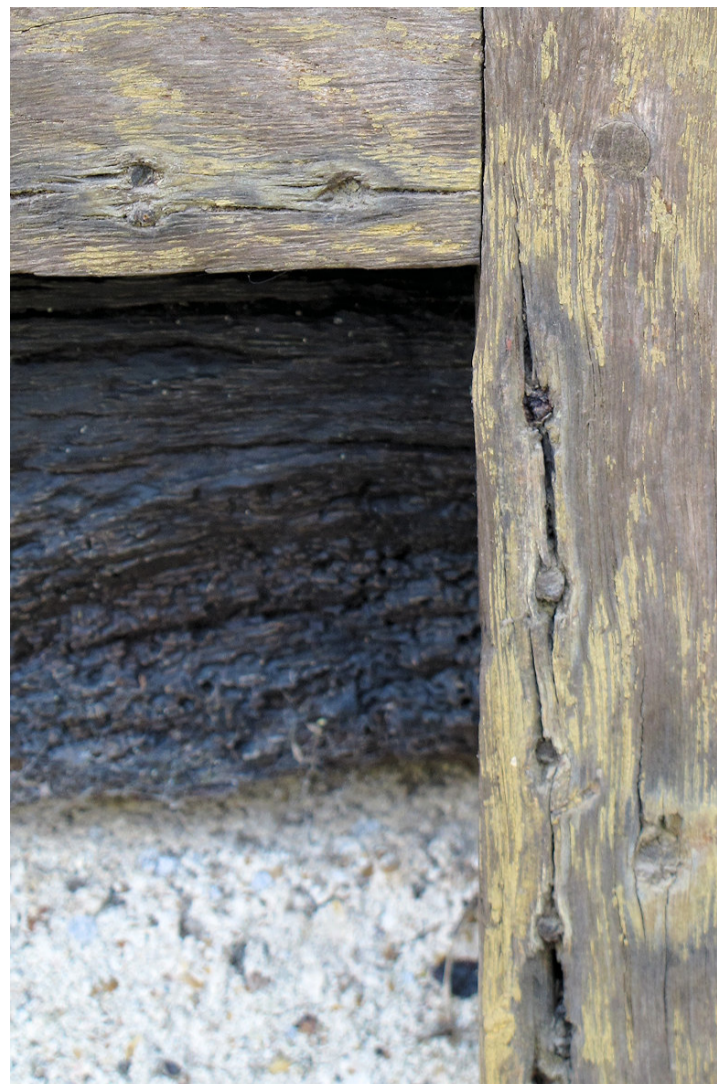
Fig. 2 - Saint-Gatien-des-Bois (Calvados) Manoir du Vilambert Châssis garni de toile (détail du clouage)
