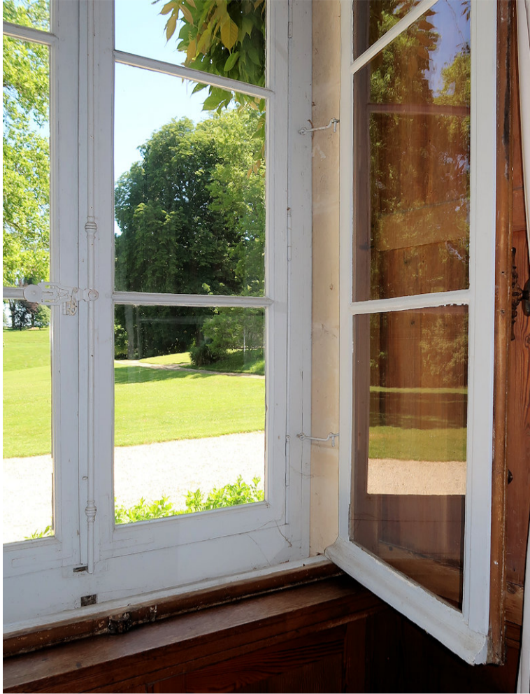
Fig. 24 - Région de Caen (Calvados) Double fenêtre vitrée maintenue par des crochets à la fenêtre intérieure
