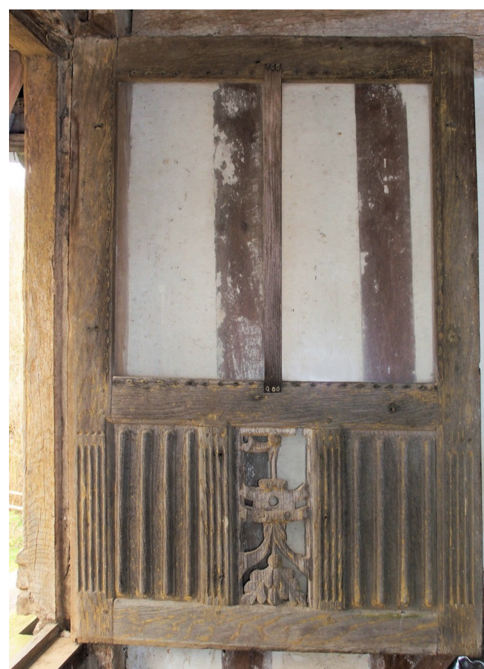
Fig. 1 - Saint-Gatien-des-Bois (Calvados) Manoir du Vilambert. Châssis garni de toile (le petit-bois vertical a été ajouté)
