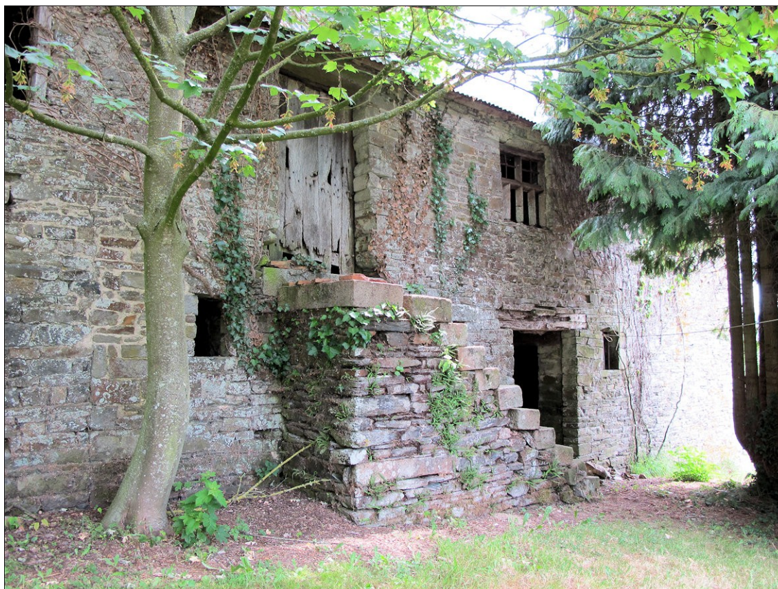
Fig. E.1. La façade antérieure (ouest)
