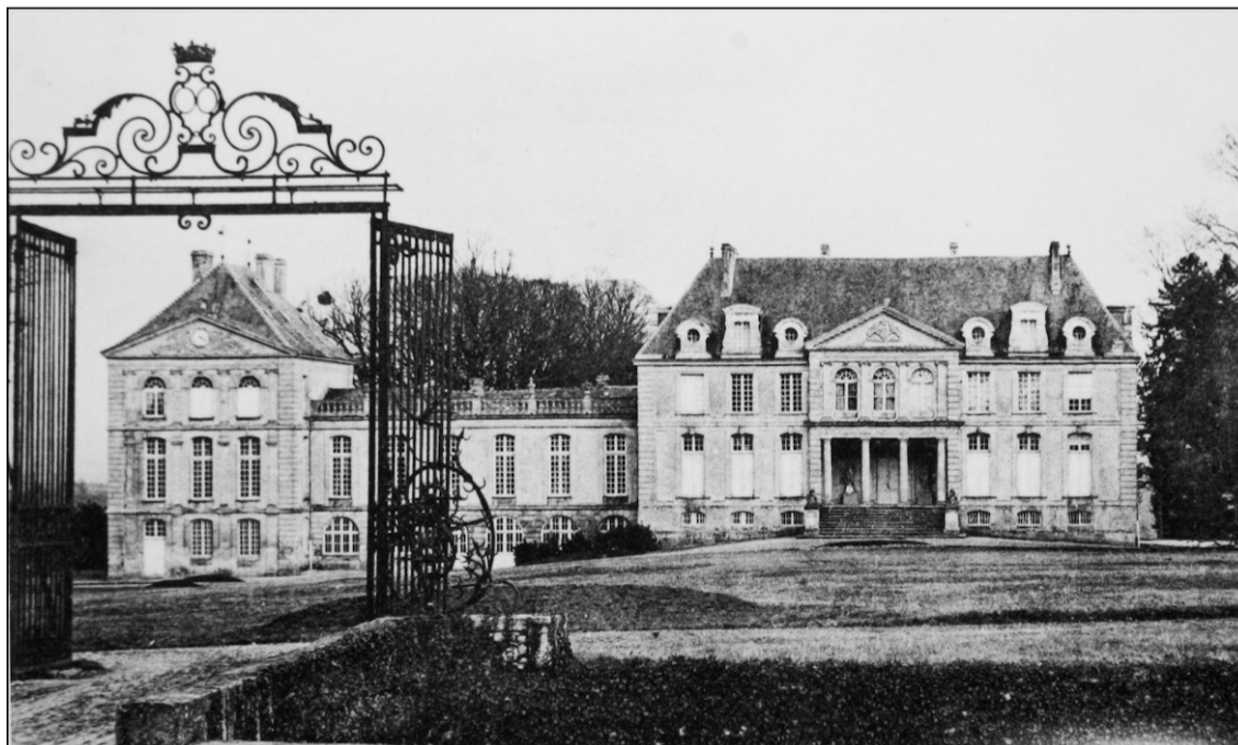
Fig. E.1. Château de Versainville à la fin du XIX e siècle (carte postale) L'aile sud n'est pas encore édifiée et les contrevents sont conservés en partie
