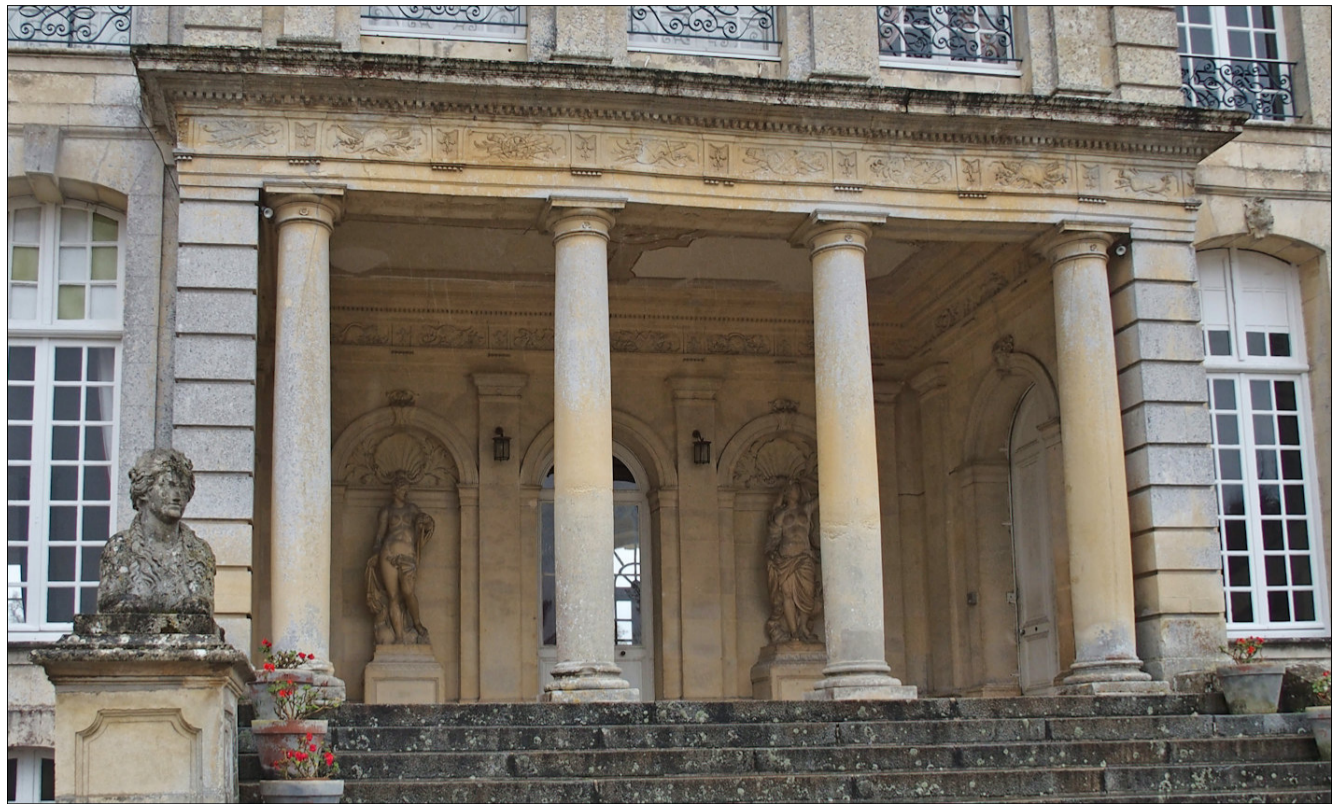
Fig. E.6. Le château de Versainville. Le vestibule.
