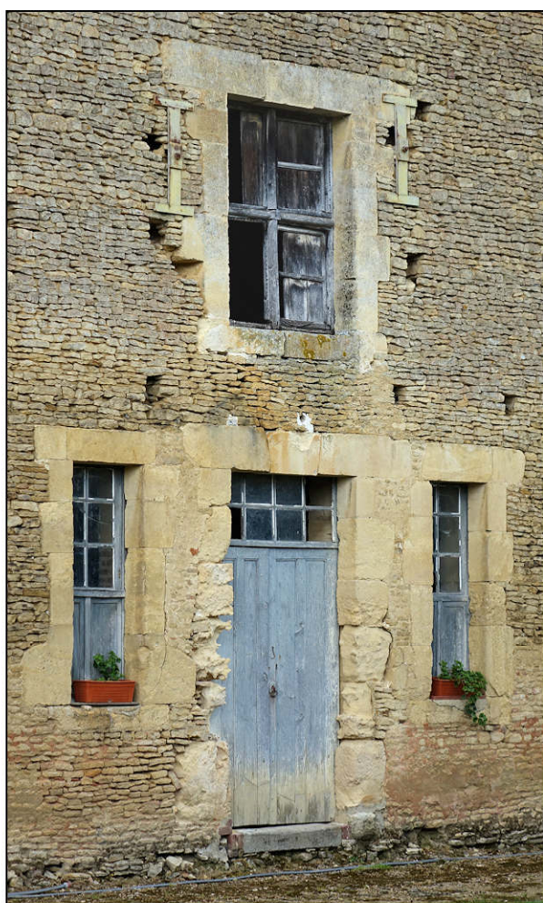
Fig. 6.2. Commun ouest (façade est)
