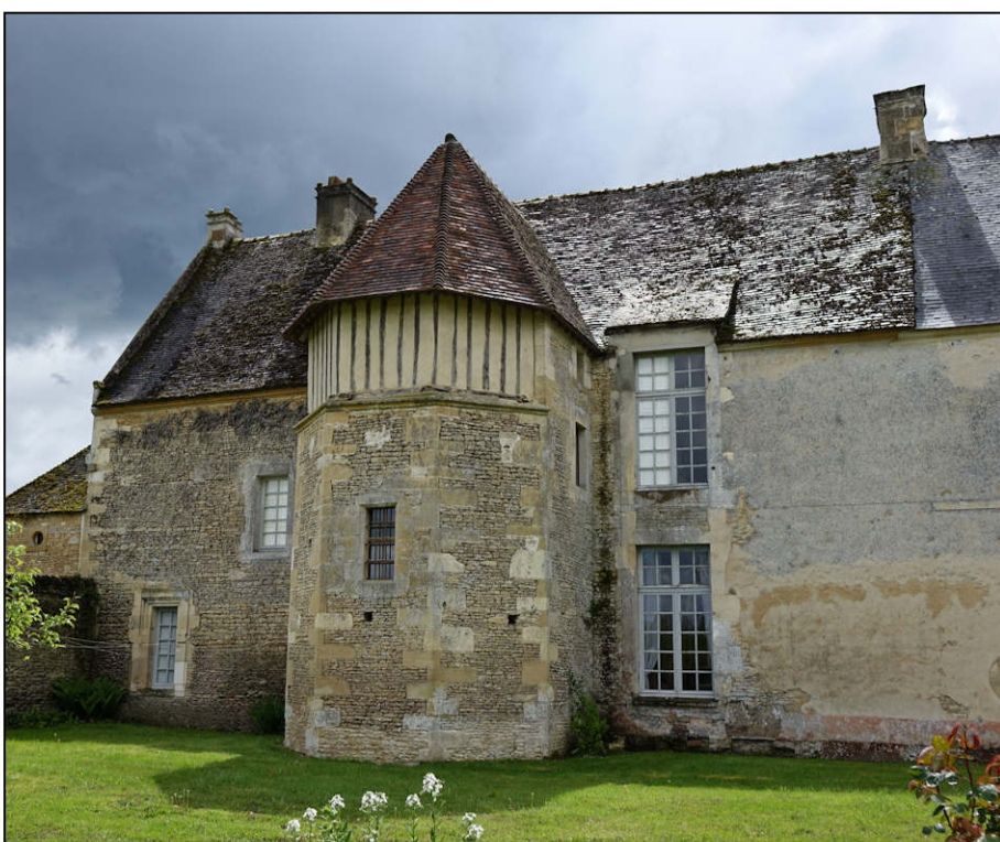
Fig. 1.4. Logis primitif (façade nord)
