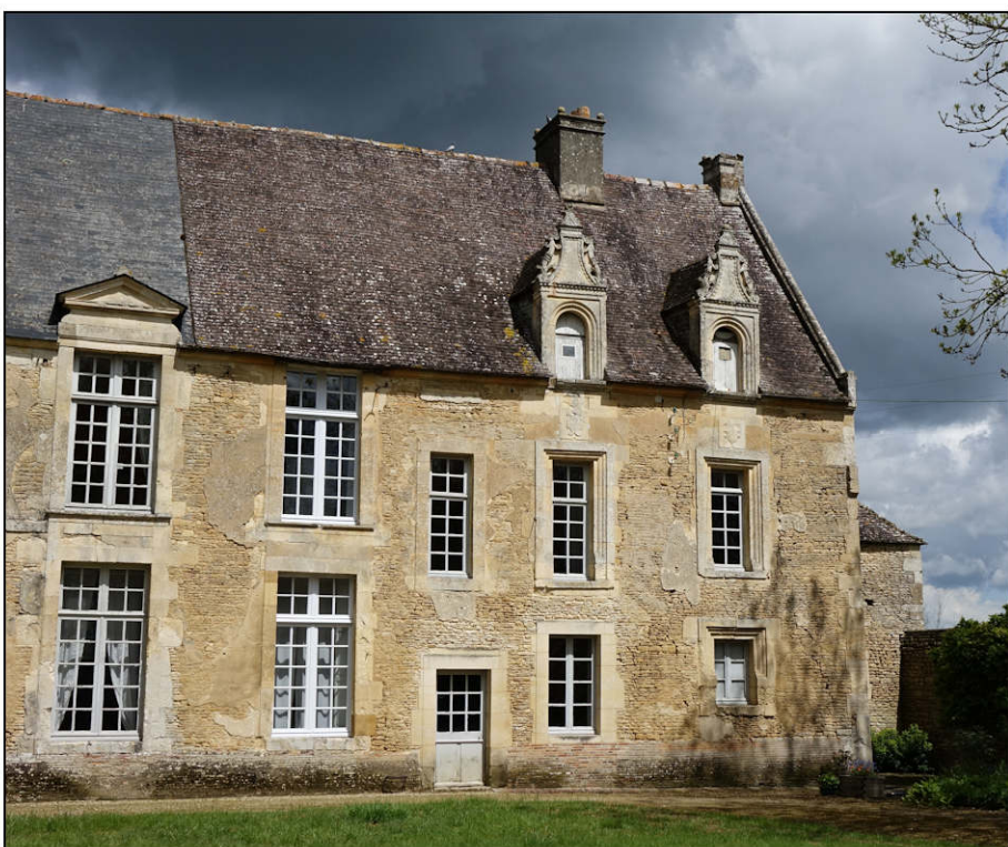
Fig. 1.2. Logis primitif (façade sud)
