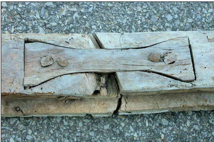
Fig. 2.3. Consolidation de la traverse
