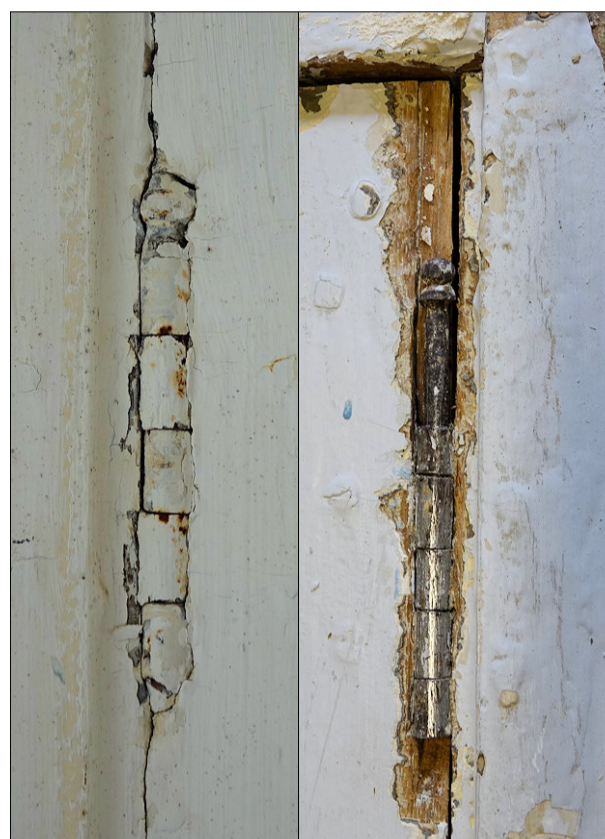
Fig. E.3. Deux fiches à bouton (sans et avec entaille pour retirer la broche)
