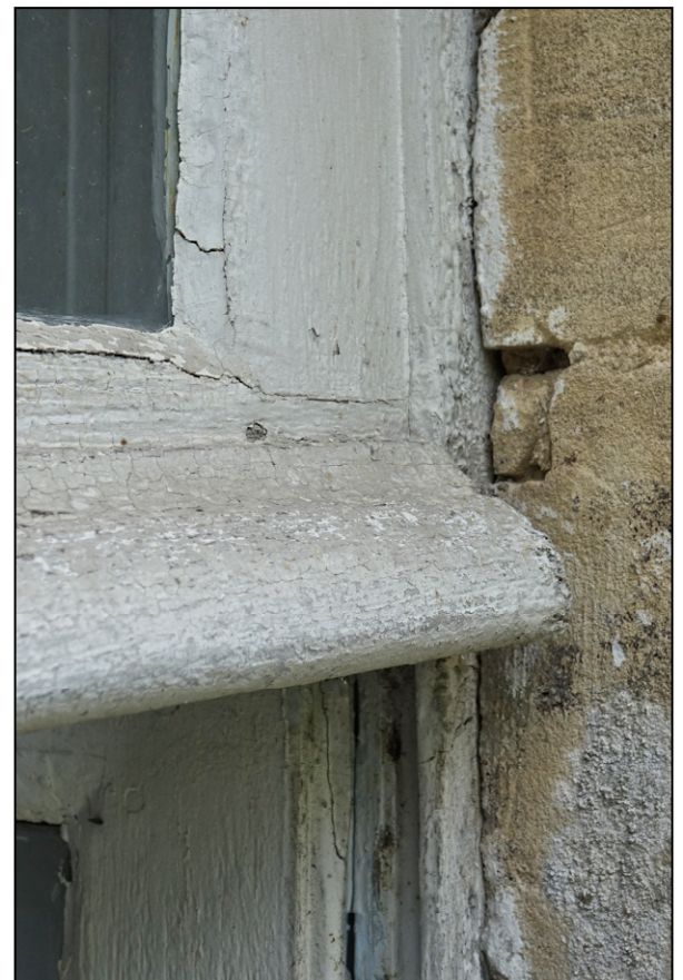
Fig. 2.5. Traverse d'imposte
