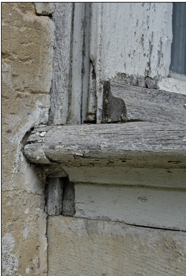
Fig. 2.3. Pièce d'appui
