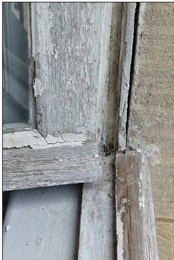
Fig. 2.4. Pièce d'appui et battant de rive
