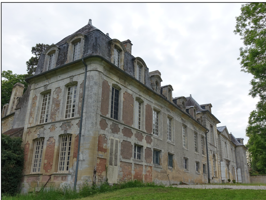
Fig. 1.3. Façade postérieure (depuis l'est)
