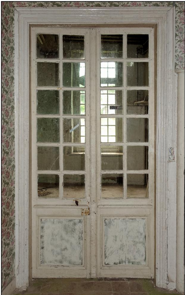
Fig. 5.4. Porte (côté arrière-cuisine)
