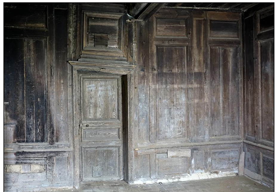
Fig. 1.4. Cloison lambrissée entre le cabinet et la chambre
