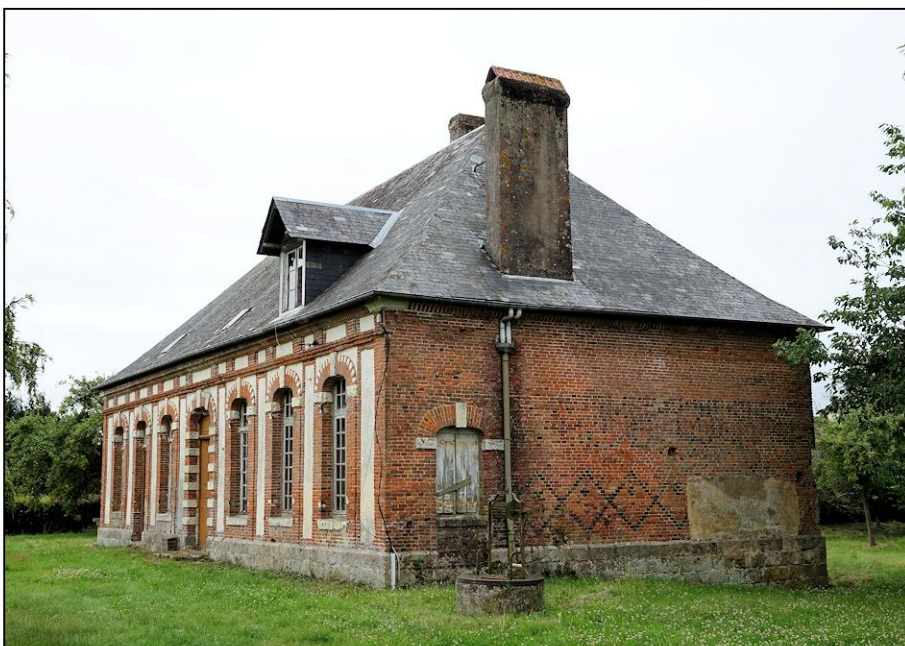
Fig. 1.3. Vue depuis le nord-est
