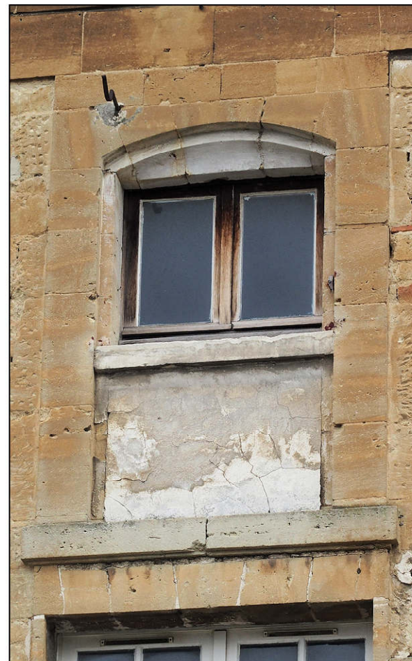
Fig. 1.2. Façade sud / fenêtre de l'étage
