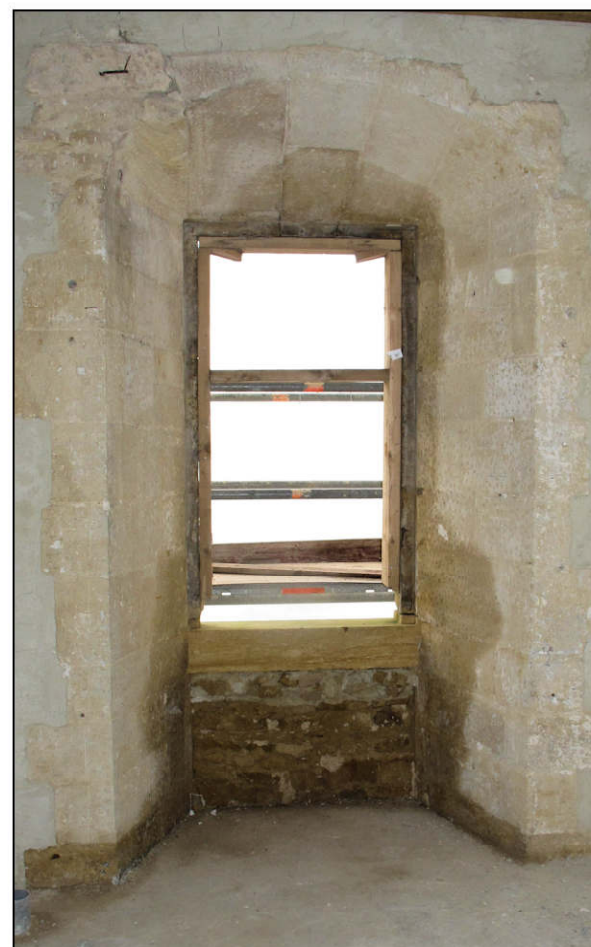
Fig. 1.4. Façade sud / fenêtre de l'étage
