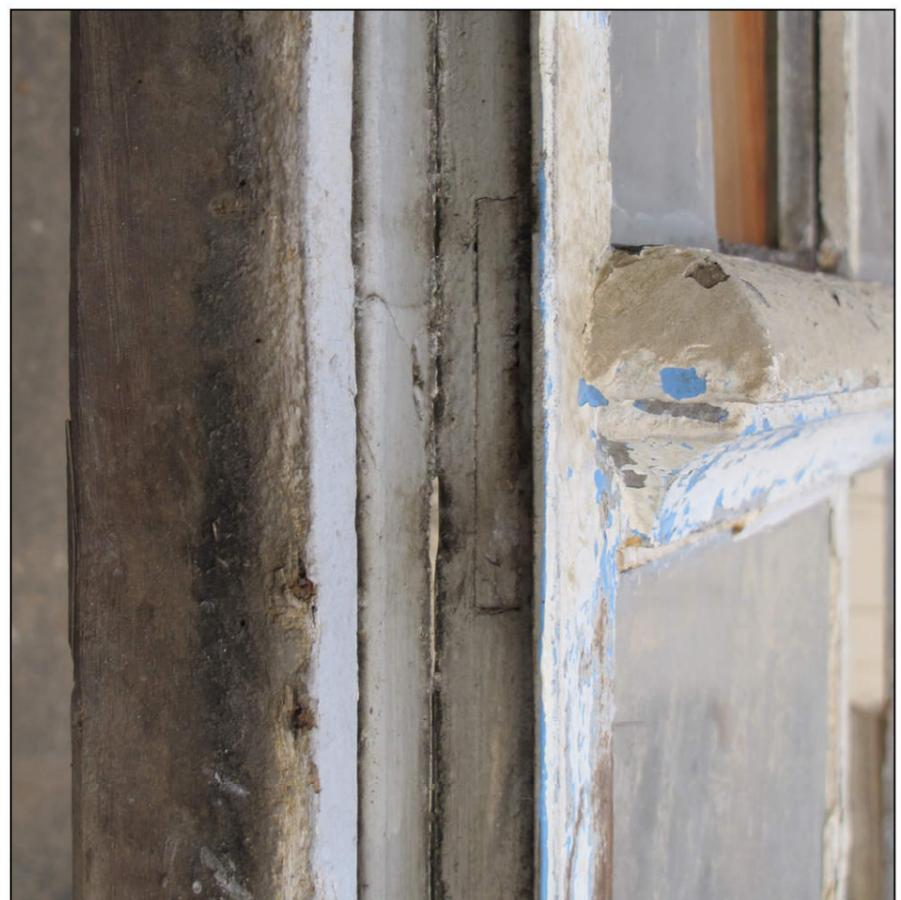
Fig. 6.5. Vantail vitré / traverse flottée (châssis D)
