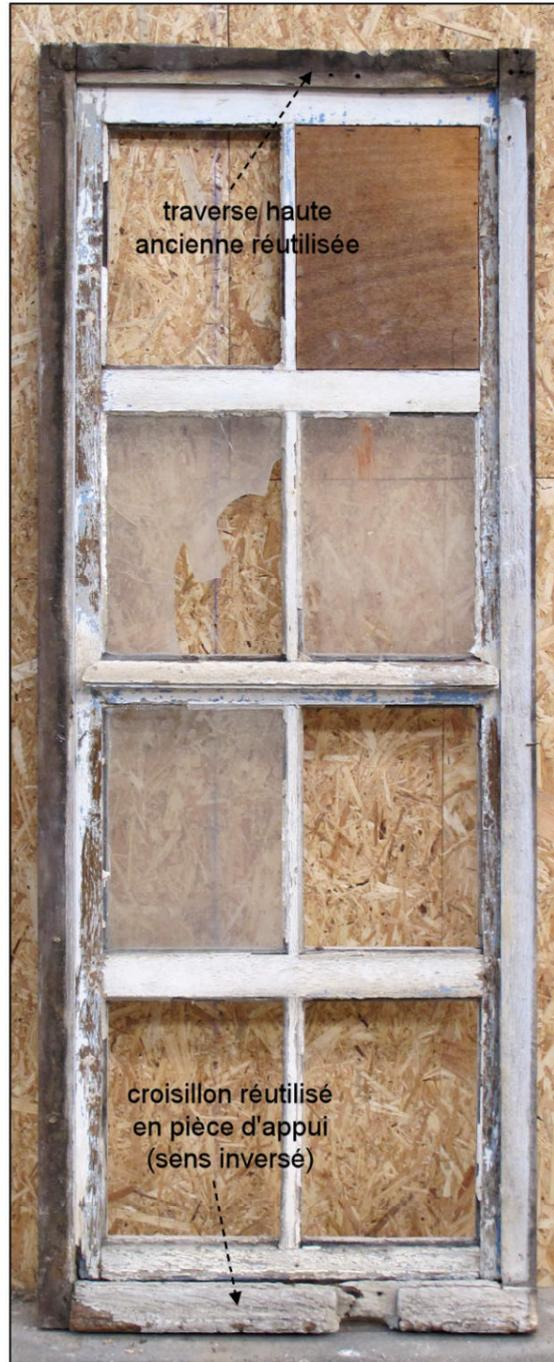
Fig. 6.2. Châssis D / élévation extérieure
