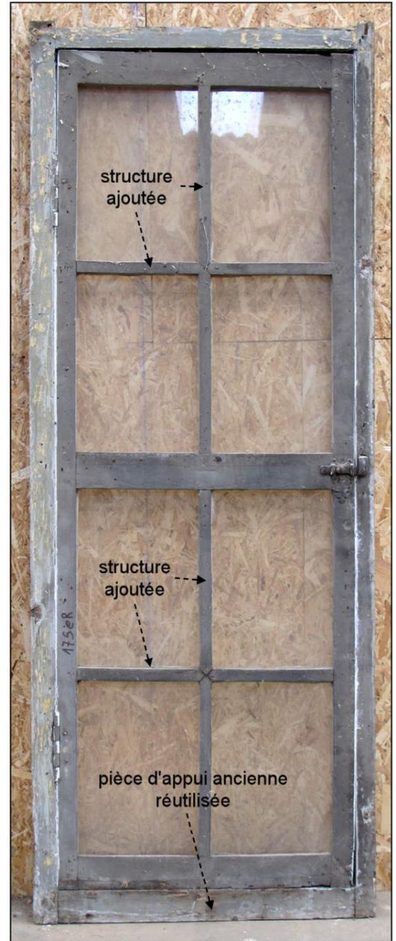
Fig. 6.3. Châssis E / élévation intérieure
