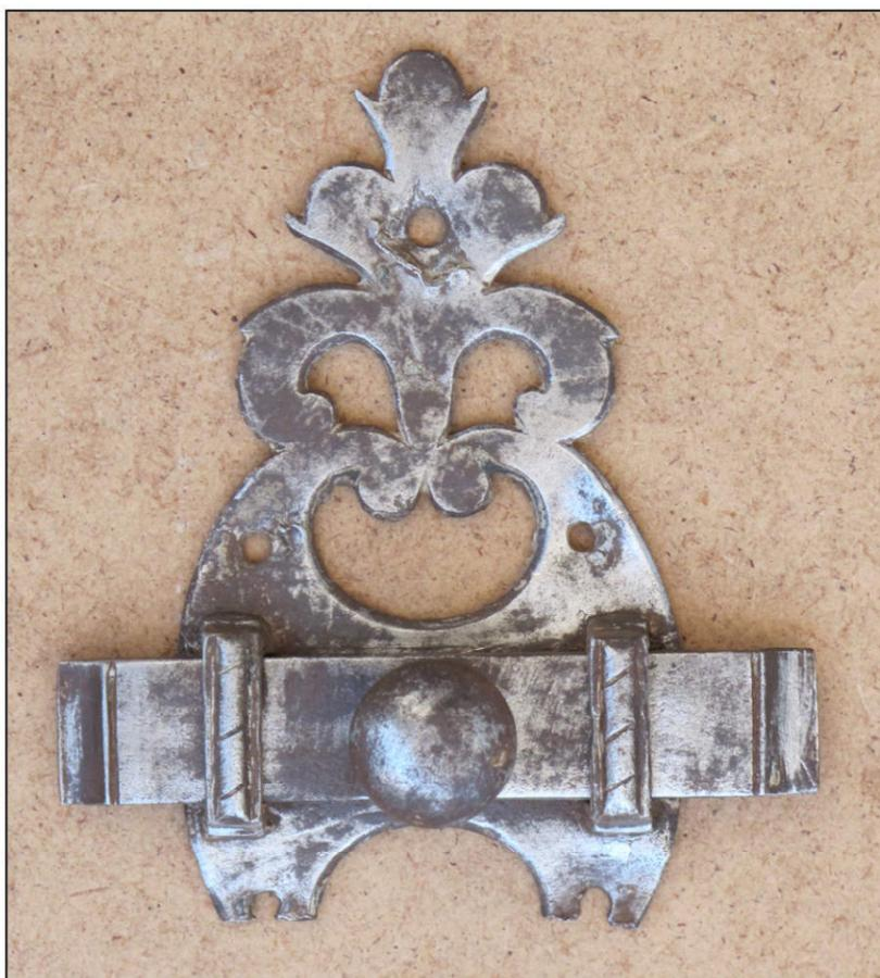
Fig. 6.4. Targette (châssis E)
