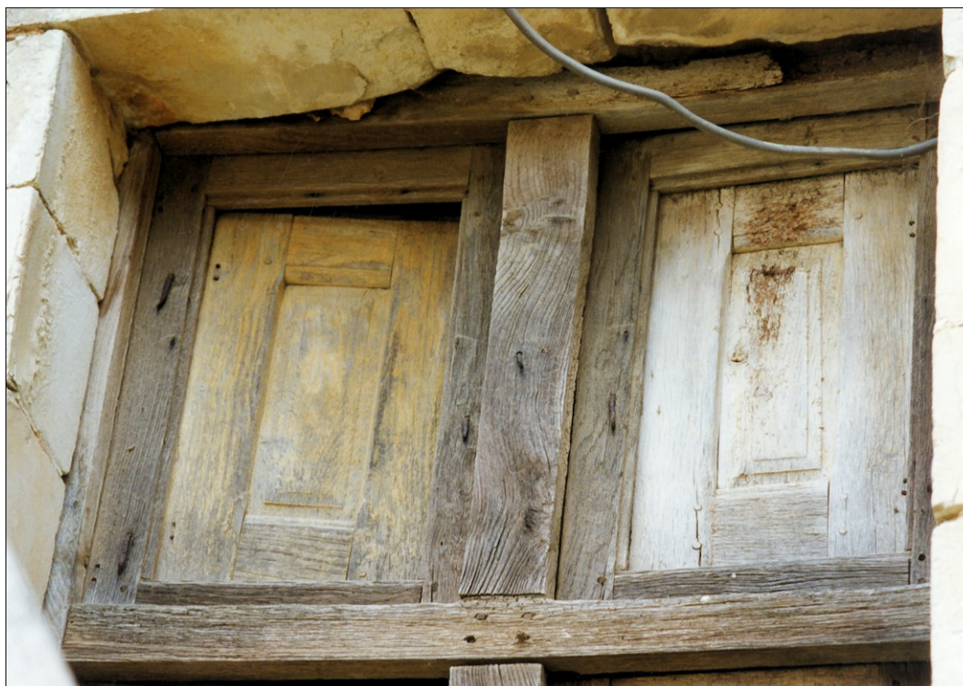
Fig. E.2. Les compartiments du haut de la croisée. A noter, les traces de peinture ocre jaune sur les volets
