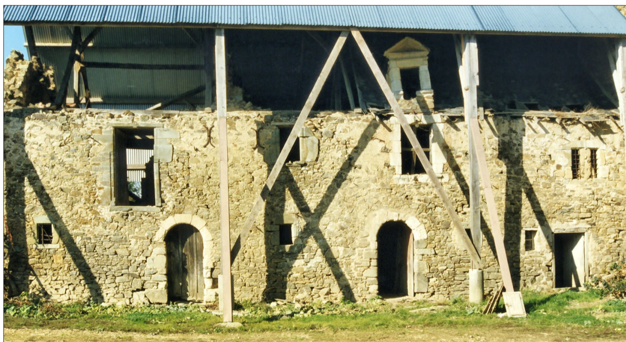
Fig. E.1. Le vieux logis avant sa restauration (état en 1996) Au premier étage, sous la lucarne, la croisée conservée.
