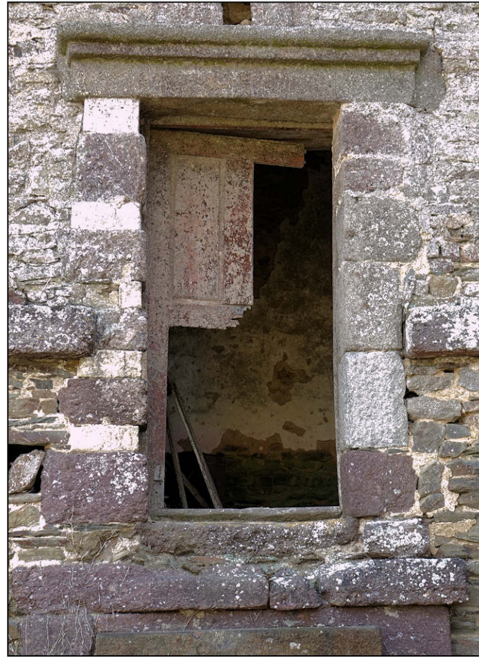
Fig. 2.3. Porte (façade N-E / 1er étage)
