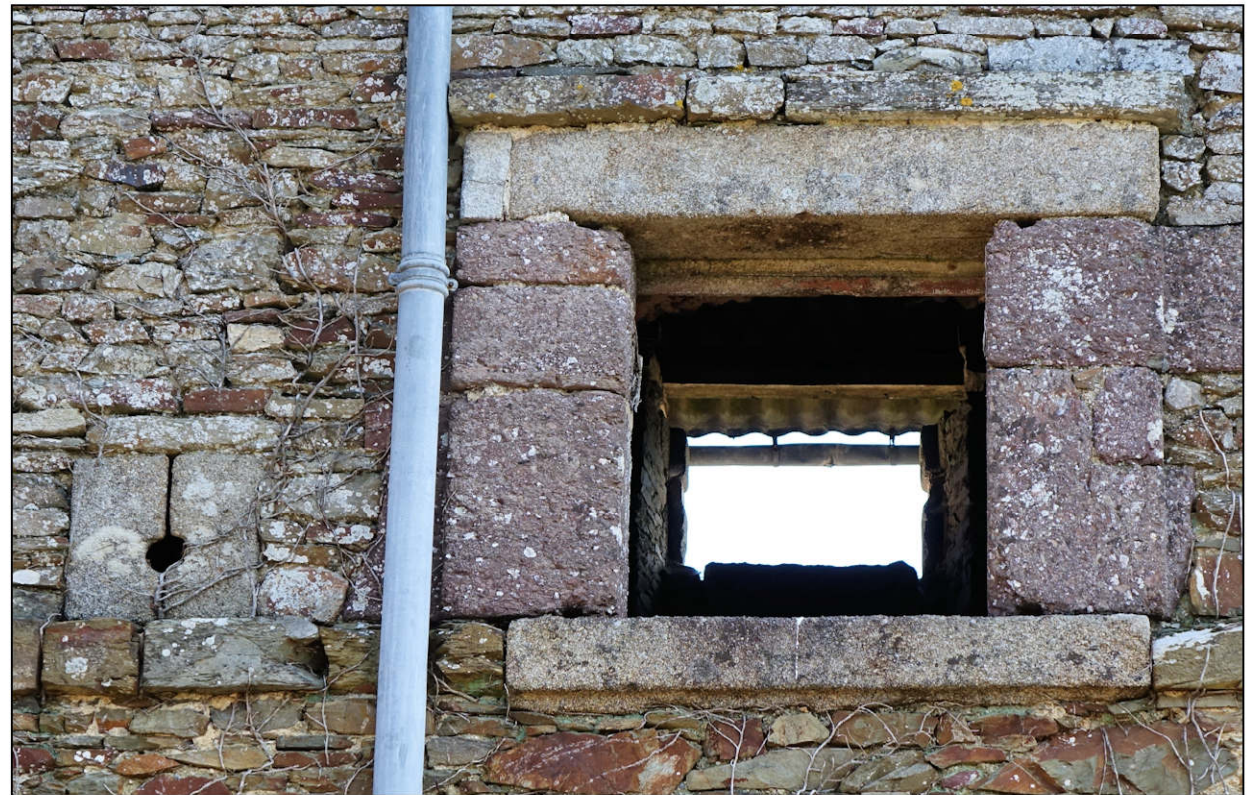
Fig. 2.6. Fenêtre (façade S-O / 1er étage)
