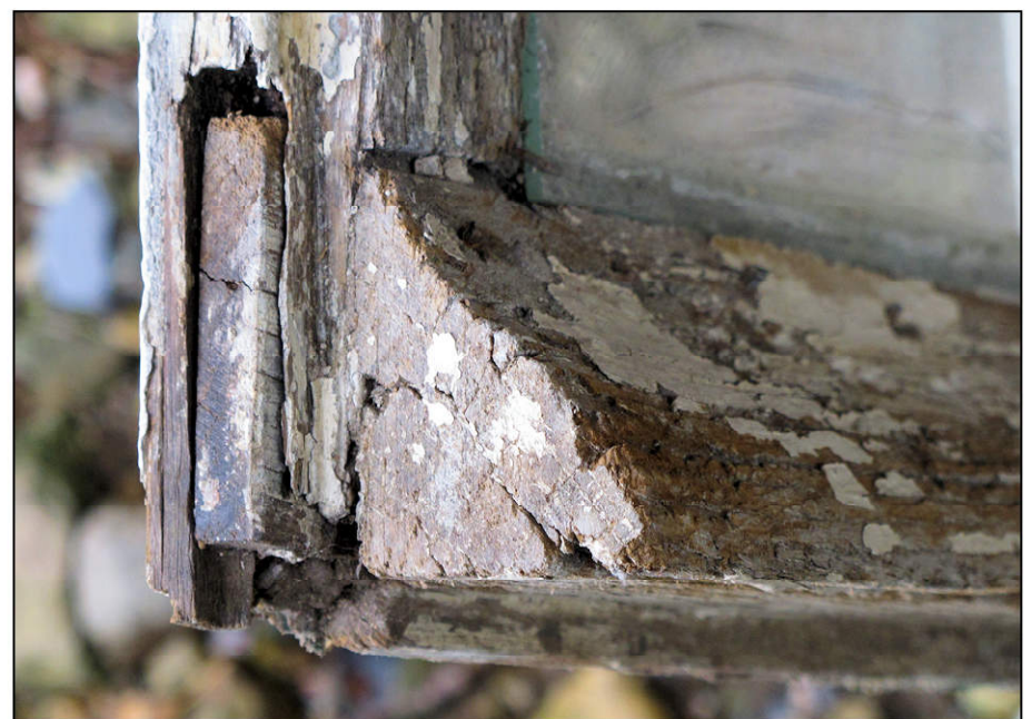
Fig. 3.7. Vantail déposé et son jet d'eau flotté
