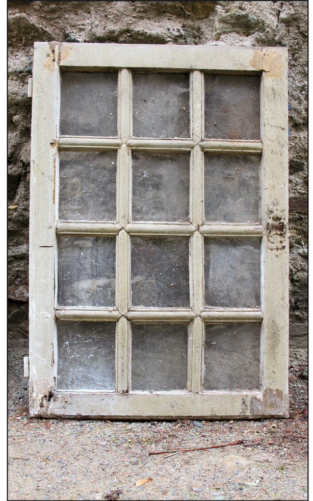
Fig. 3.3. Vantail déposé et sa targette d'origine
