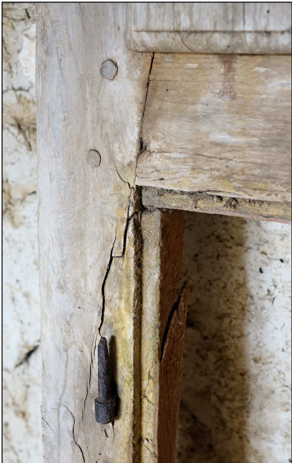
Fig. 1.3. Assemblage du croisillon
