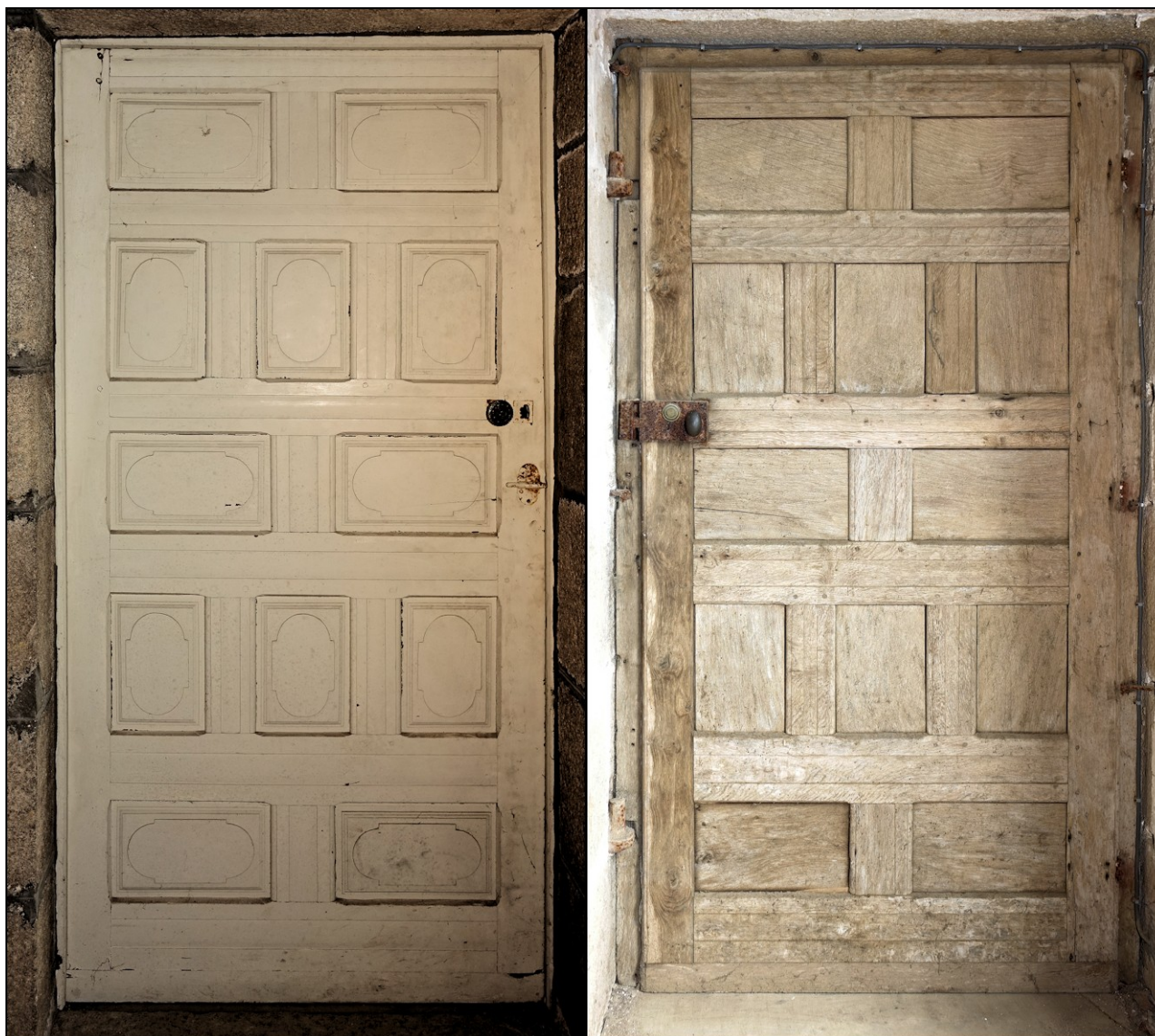
Fig. E.4. Porte donnant accès à la galerie
