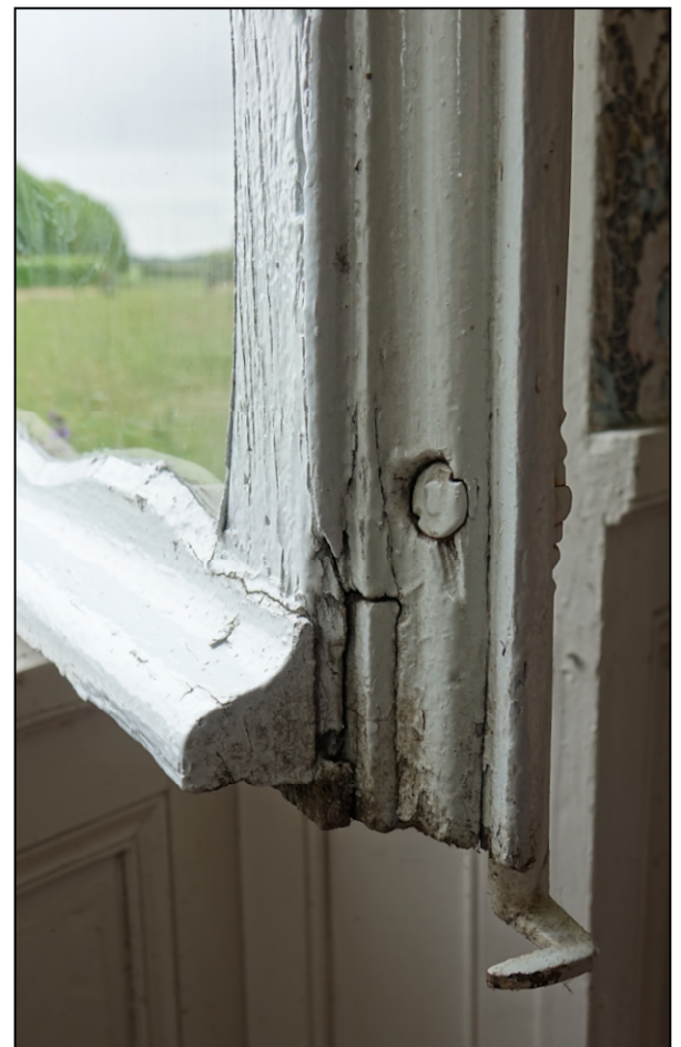
Fig. 7.5. Jet d'eau et battant du milieu
