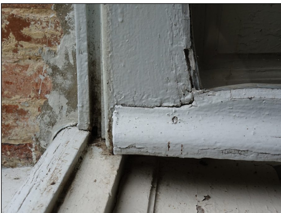
Fig. 7.6. Pièce d'appui et jet d'eau
