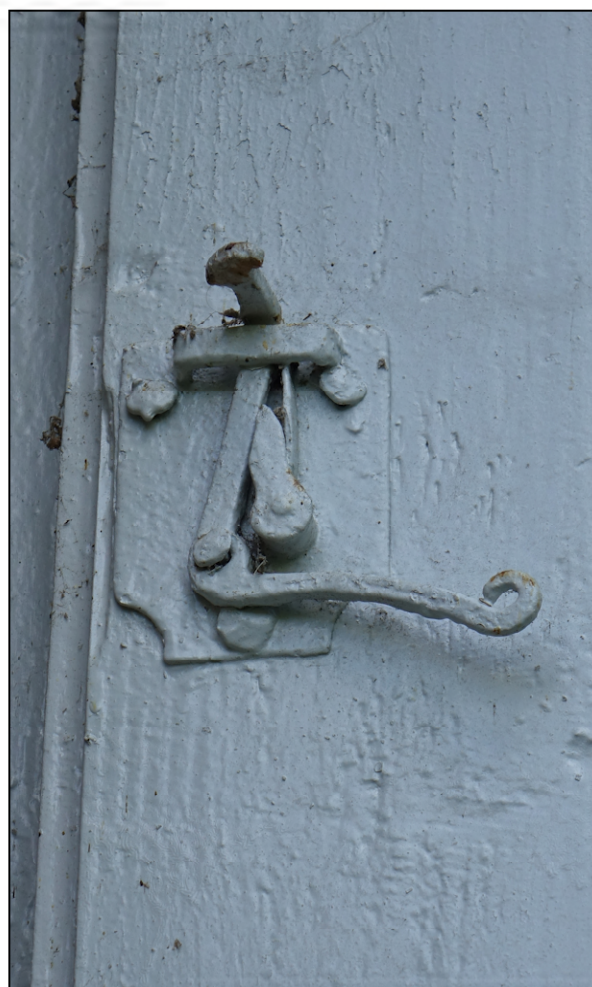
Fig. 5.5. Loquet à ressort (contrevent)
