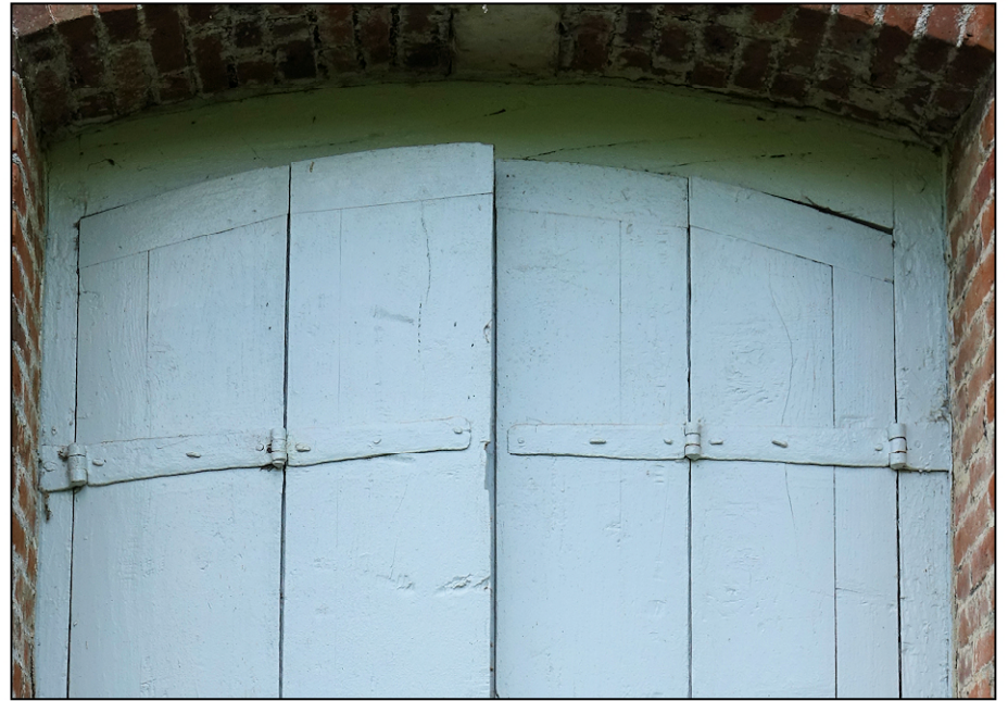
Fig. 5.2. Ferrures des contrevents
