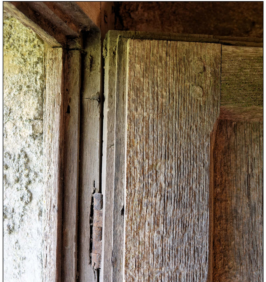
Fig. 4.4. Bâti dormant / volet sup. (détail des feuillures)
