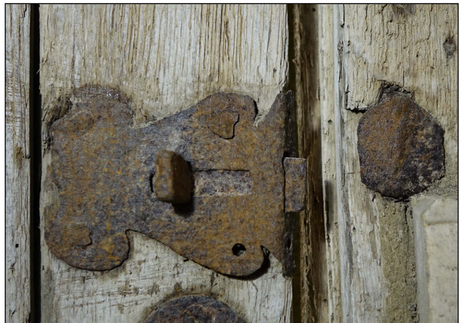
Fig. 4.6. Targette encloisonnée (vantail vitré)
