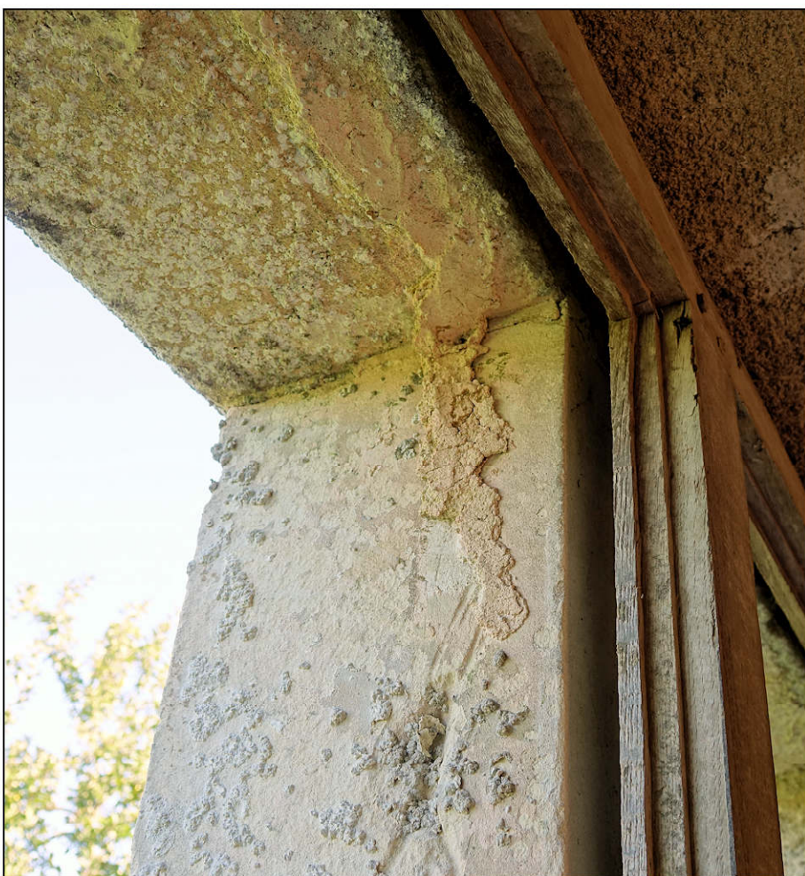
Fig. 4.5. Traces de l'ancienne vitrerie (solins et entaille dans le tableau)
