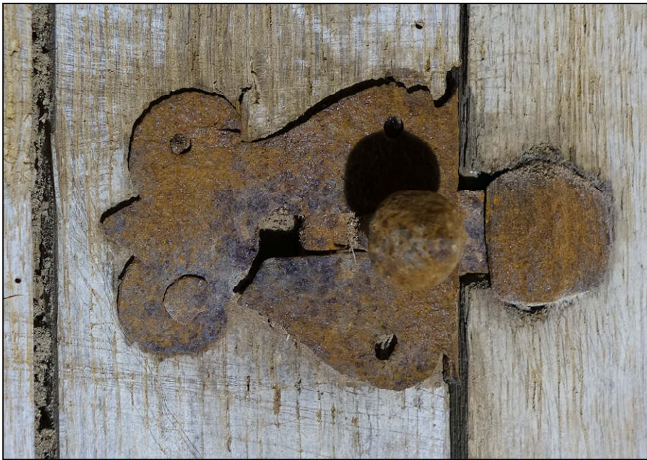
Fig. 4.3. Targette encloisonnée (volet)
