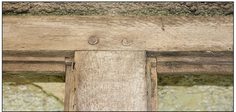
Fig. 3.4. Bâti dormant (montant intermédiaire / traverse haute)
