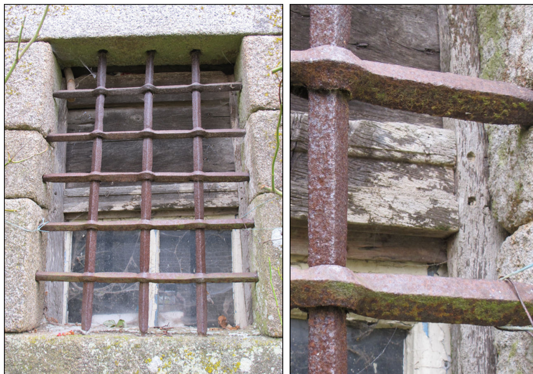
Fig. E.2. Fenêtre du rez-de-chaussée de la façade ouest
