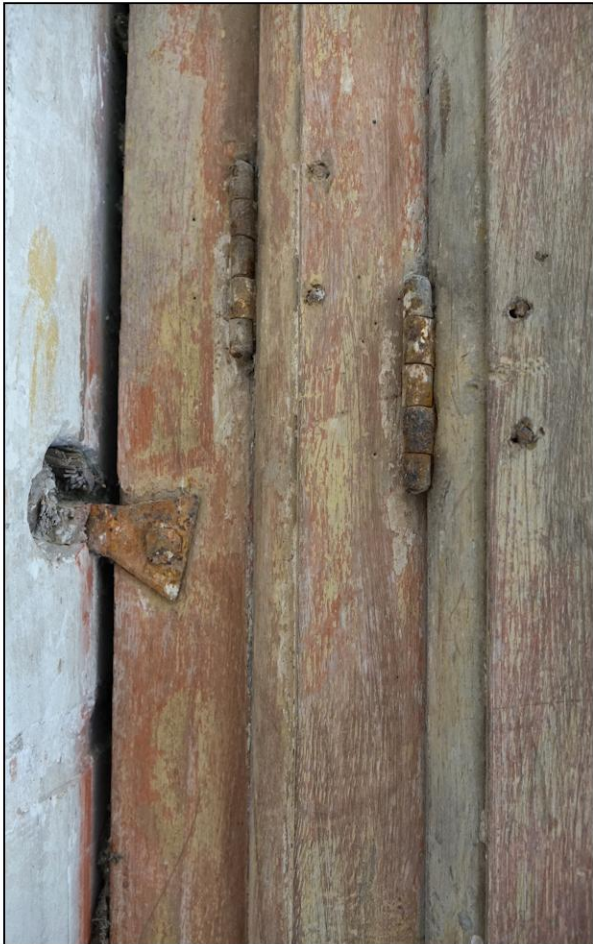
Fig. 4.1. Patte à sceller et fiches
