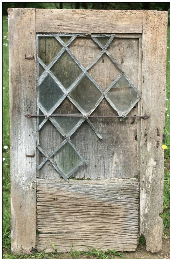
Fig. 1.5 - Châssis (élévation extérieure)
