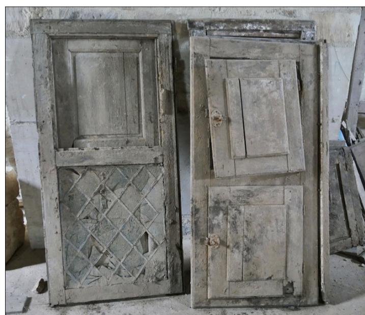
Fig. E.1. et E.2. Les châssis réutilisés sur un plancher et mis au jour Photos Jacky Turquety (ministère de la Culture)
