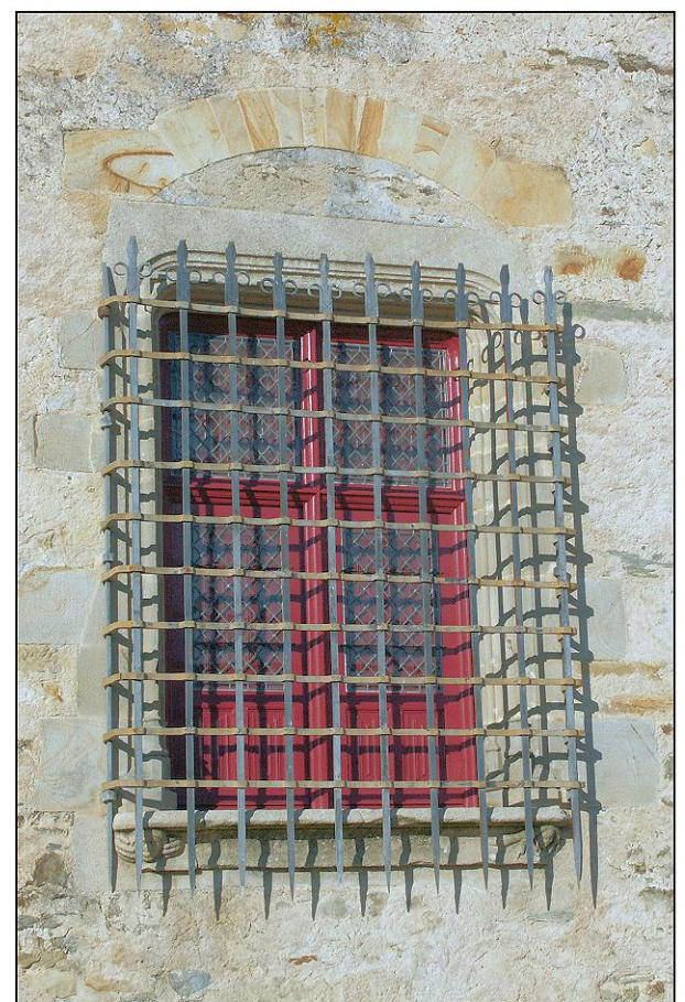
Fig. 1.4. Fenêtre sud (à droite de la porte)
