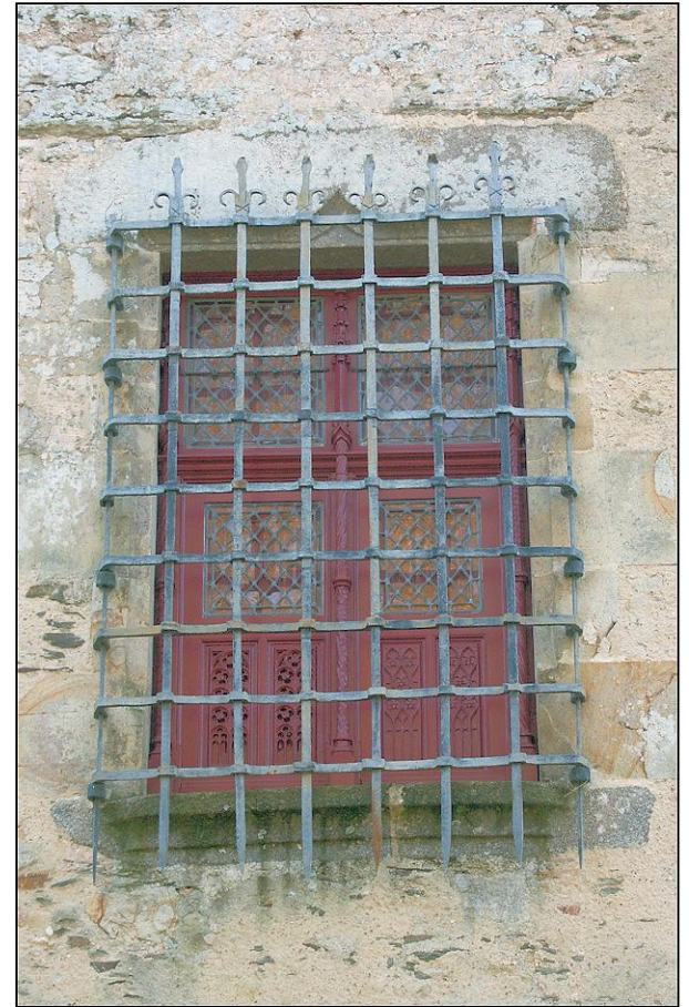
Fig. 1.2. Fenêtre nord (croisée restituée)
