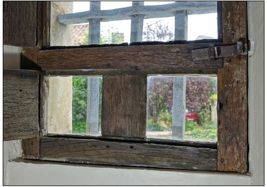
Fig. 2.2. Soubassement à panneaux (supprimés)
