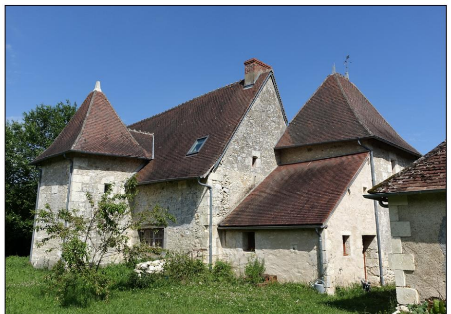
Fig. 1.3. Façades nord-ouest et sud-ouest
