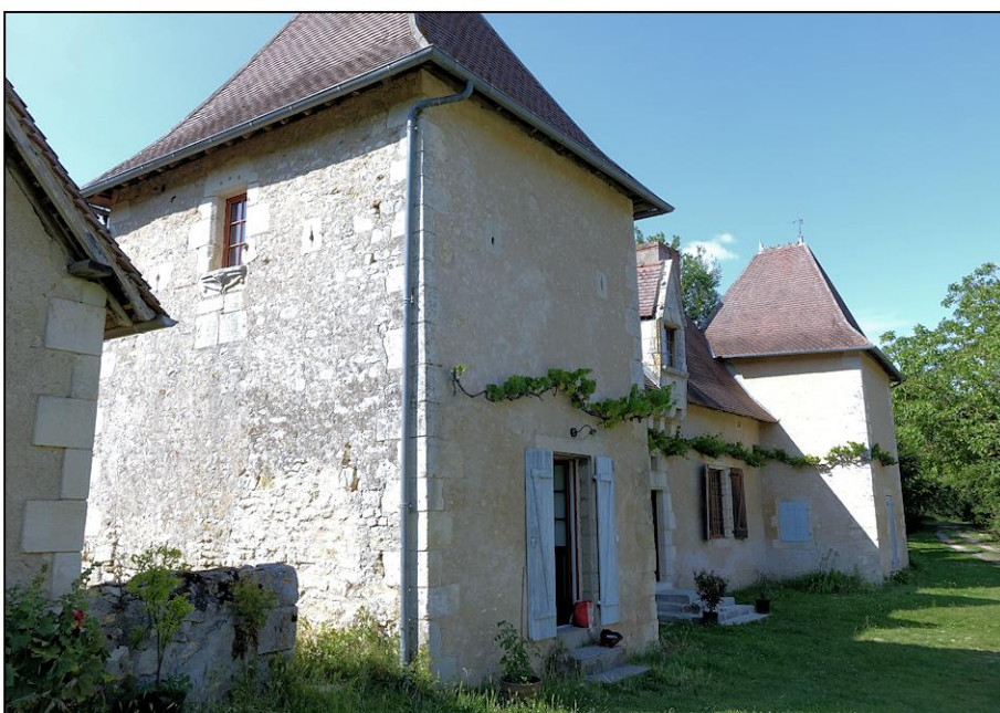
Fig. 1.2. Façades sud-ouest et sud-est
