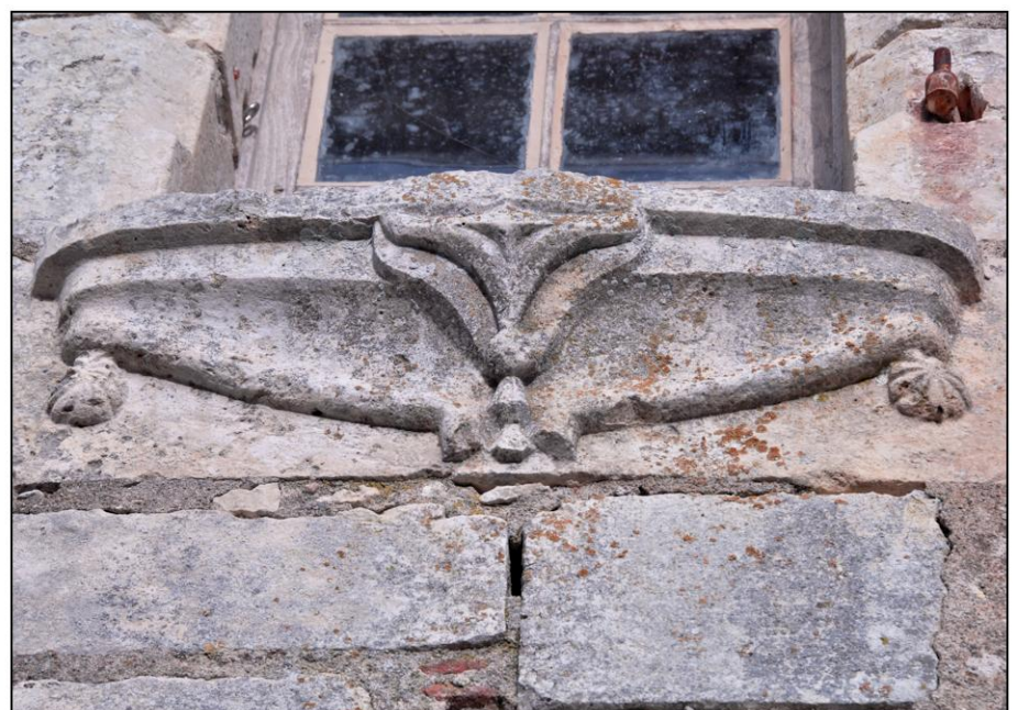
Fig. 1.5. Appui de la fenêtre en façade sud-ouest (fig. 1.2)
