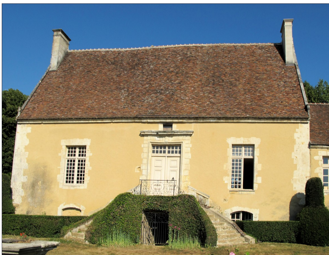
Fig. E.1. Façade orientale
