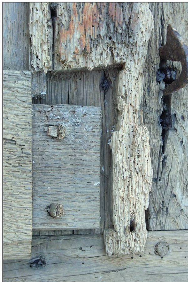
Fig. 1.4. Assemblage à tenon et mortaise
