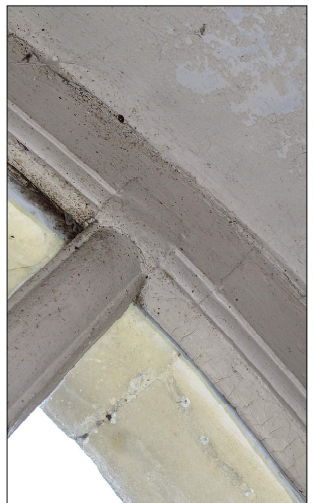
Fig. 2.5. Petit-bois en raccord avec le cintre
