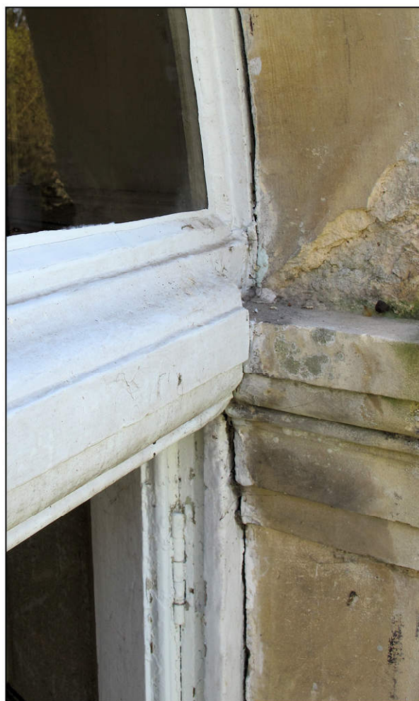
Fig. 2.4. Traverse d'imposte
