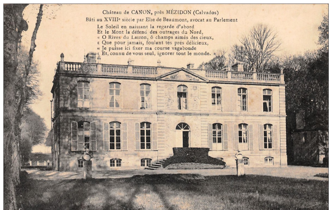
Fig. E.1. Château de Canon au début du XIXe siècle (façade ouest) Carte postale Fillion à Lisieux
