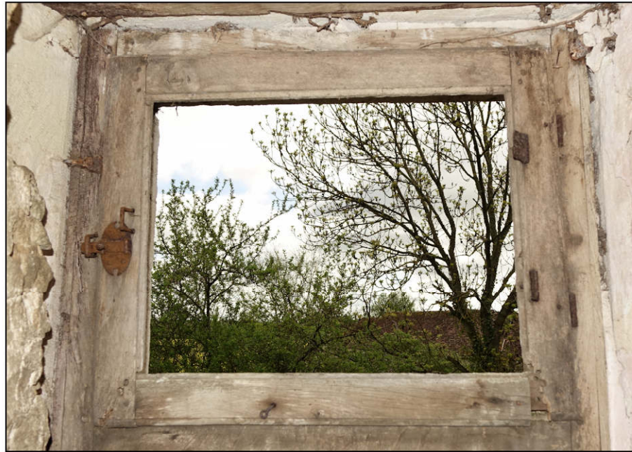
Fig. 3.2. Vantail vitré supérieur (élévation intérieure)
