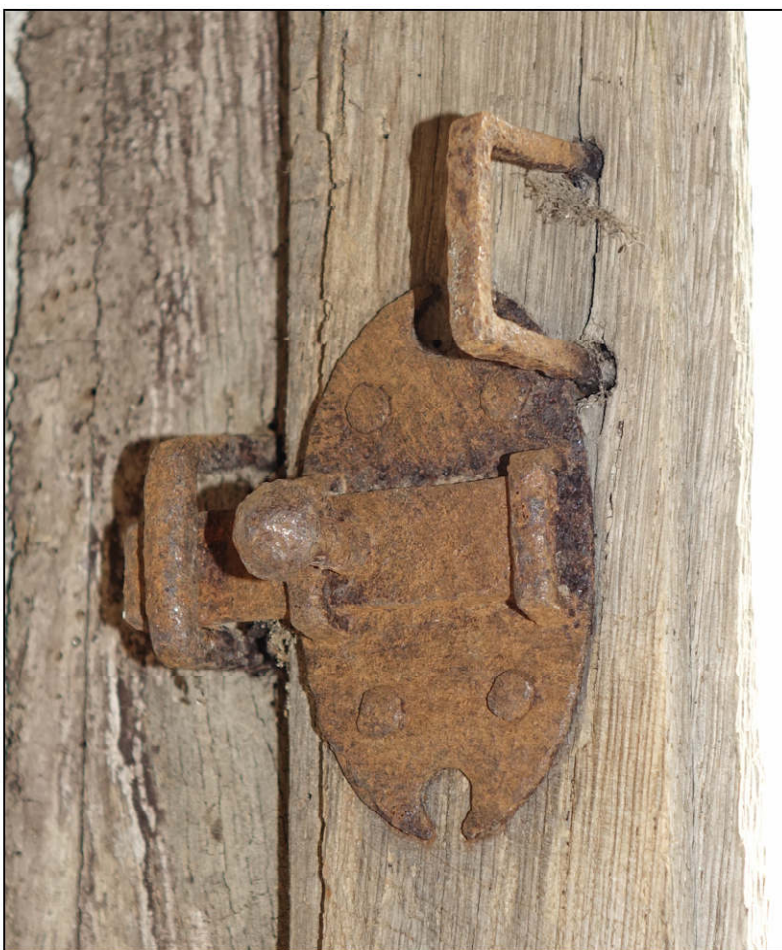
Fig. 3.3. Targette (vantail supérieur)
