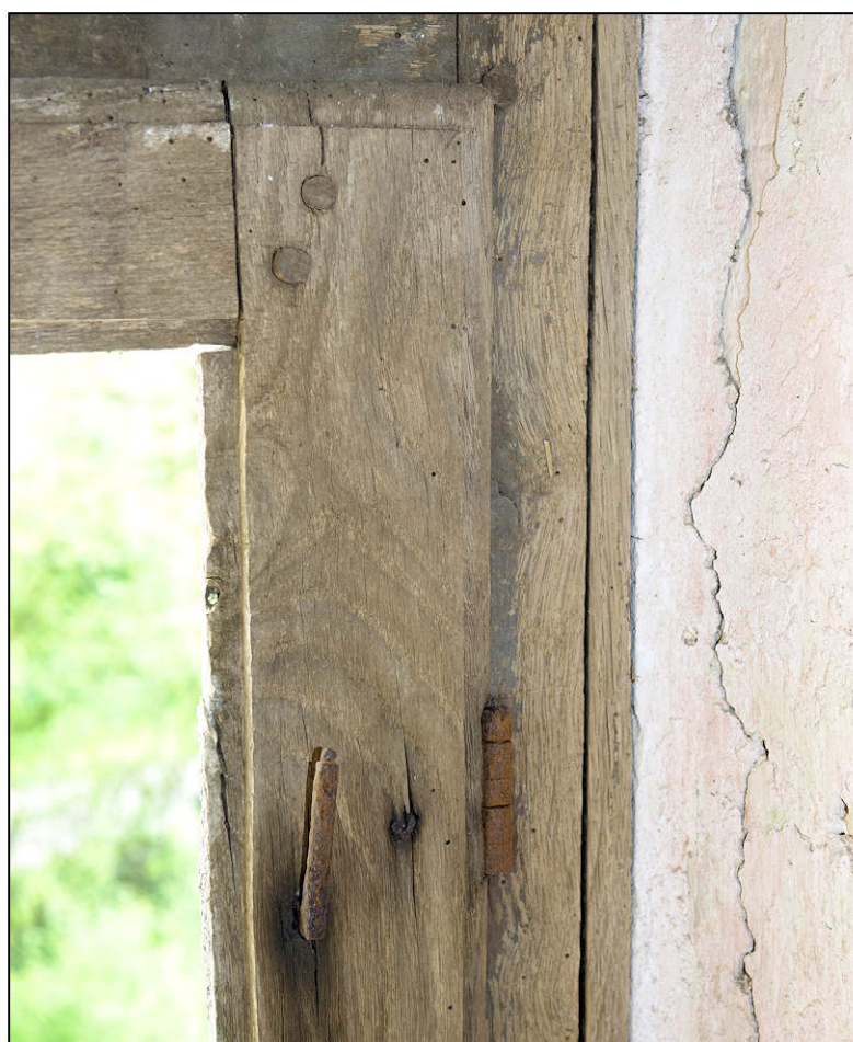
Fig. 3.6. Fiche à gond et fiche à broche rivée (vantail inférieur)
