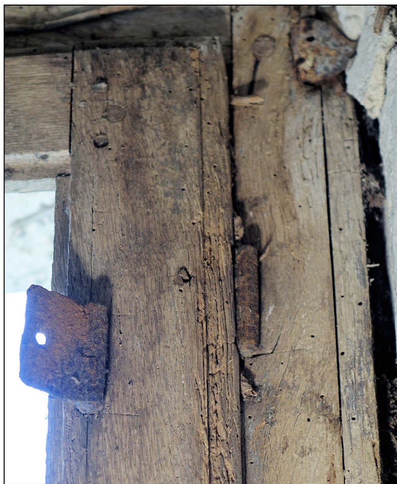
Fig. 3.4. Fiches à broche rivée (vantail supérieur)
