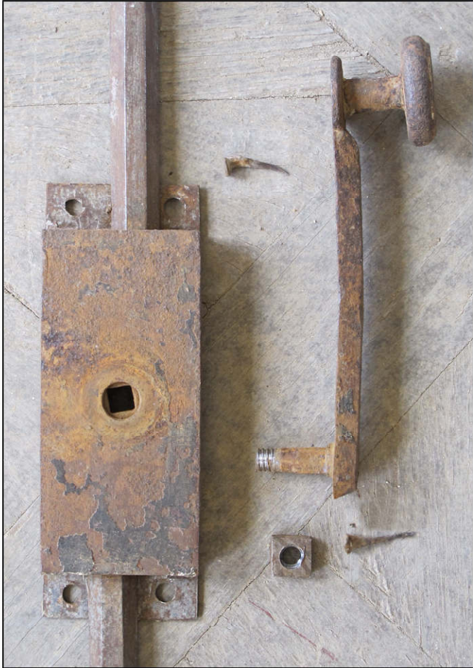
Fig. 9.1. Verrou à bascule
