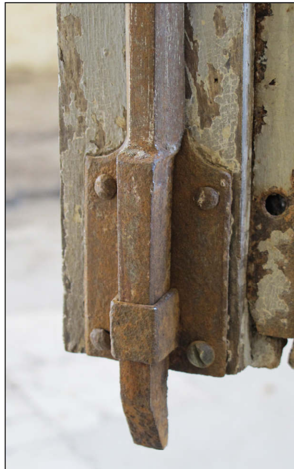
Fig. 9.5. Verrou inférieur
