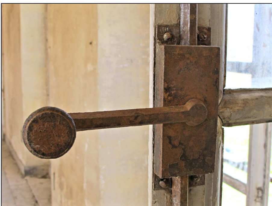
Fig. 9.7. Bascule et poignée
