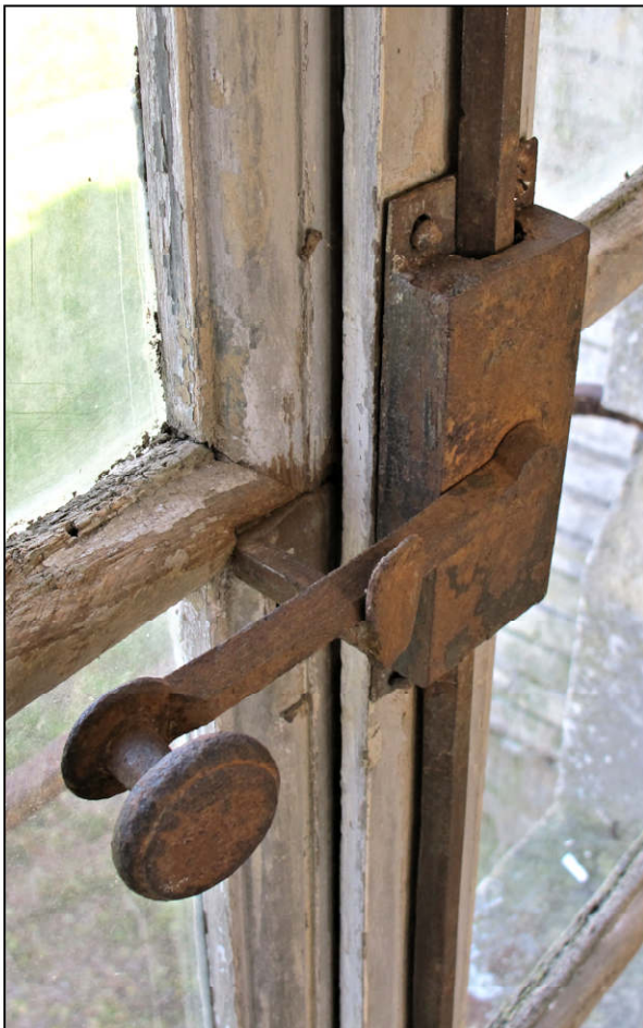
Fig. 9.4. Poignée et arrêt
