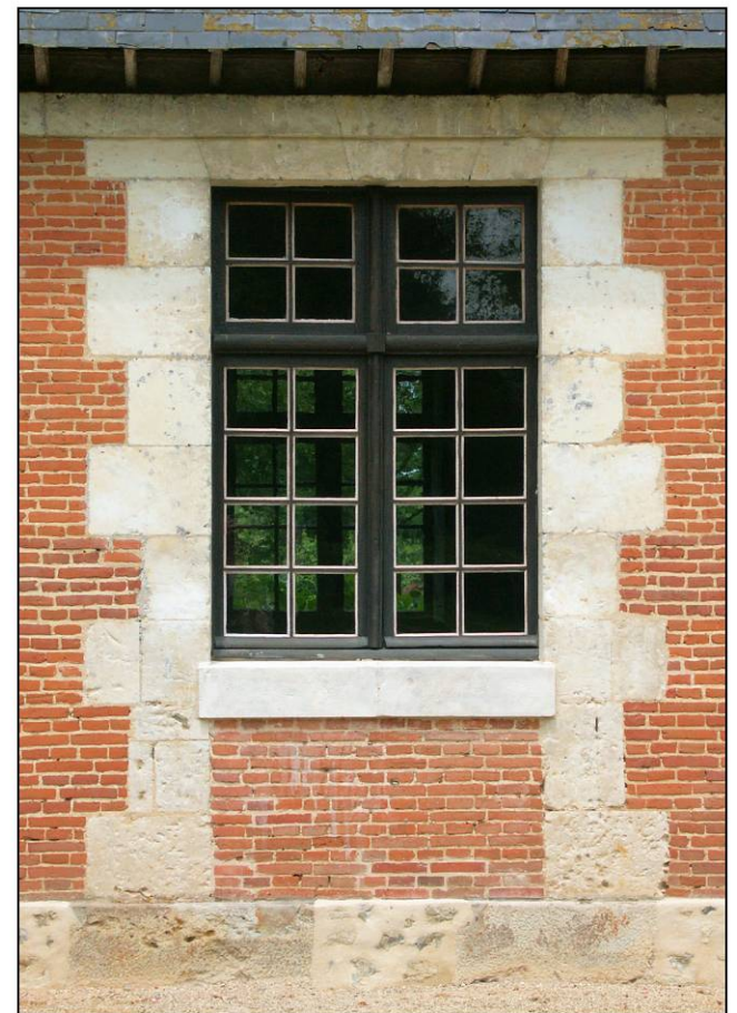
Fig. 5.4. Fenêtre du rez-de-chaussée
