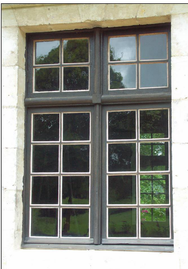
Fig. 5.5. Fenêtre du rez-de-chaussée
