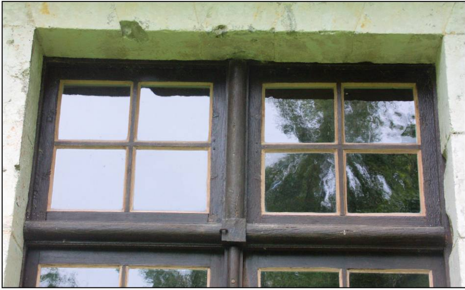
Fig. 5.1. Rez-de-chaussée / compartiments supérieurs (extérieur)
