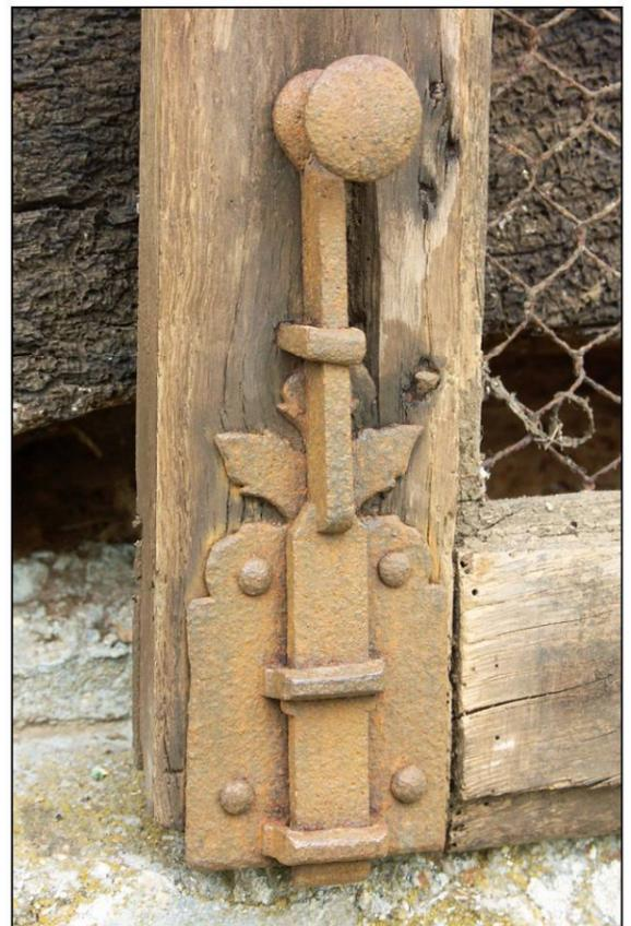
Fig. 3.6. Verrou (modification du ferrage)
