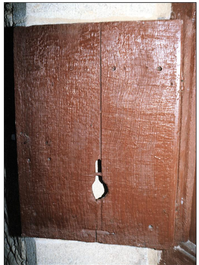
Fig. 3.4. Volet (élévation ext. / après restauration)
