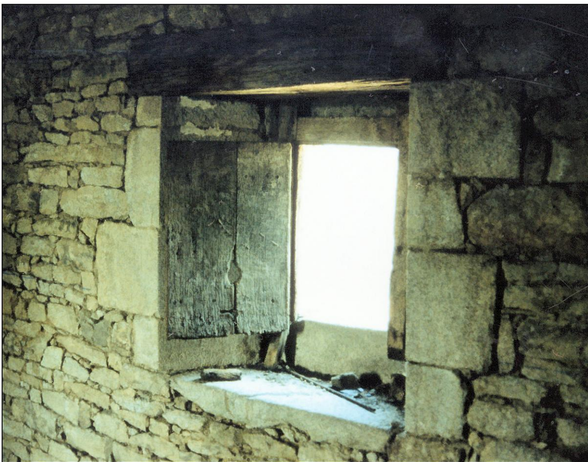
Fig. 3.3. Volet (élévation extérieure / avant restauration)
