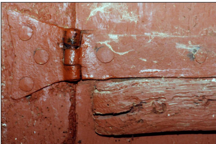
Fig. 3.5. Charnière inférieure (détail)
