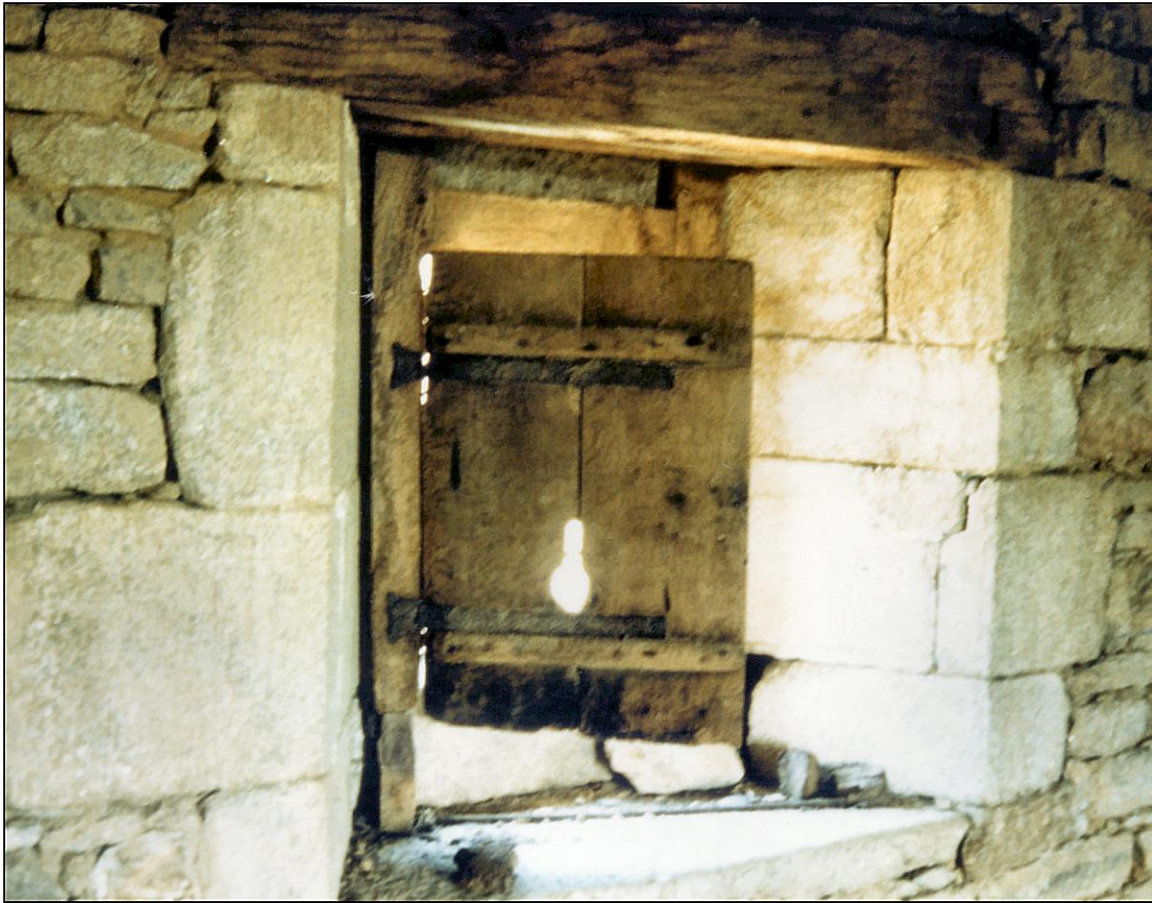
Fig. 3.1. Volet (élévation intérieure / avant restauration)
