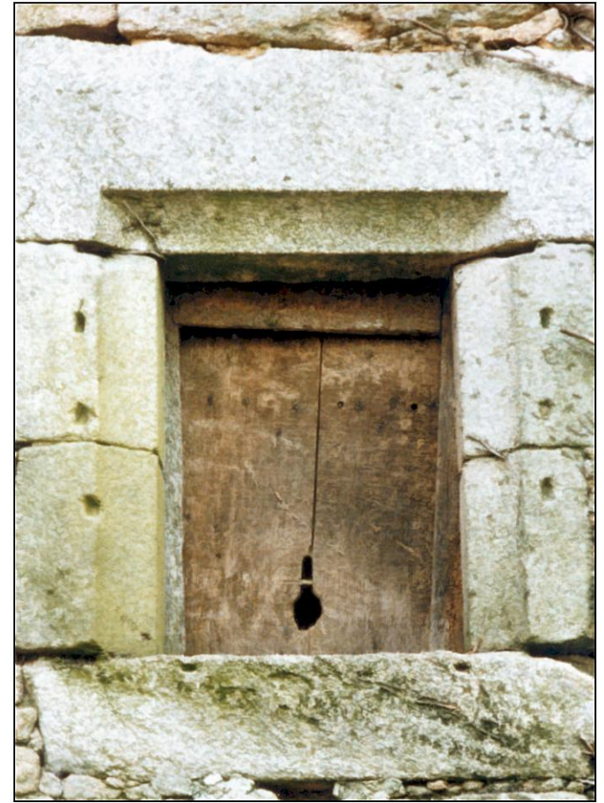
Fig. 3.2. Fenêtre (élévation ext. / avant restauration)
