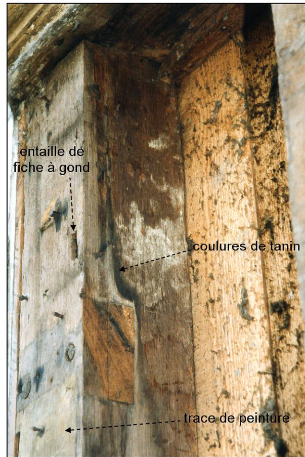
Fig. 3.3. Travée 5 / poteau-traverse (assemblage)
