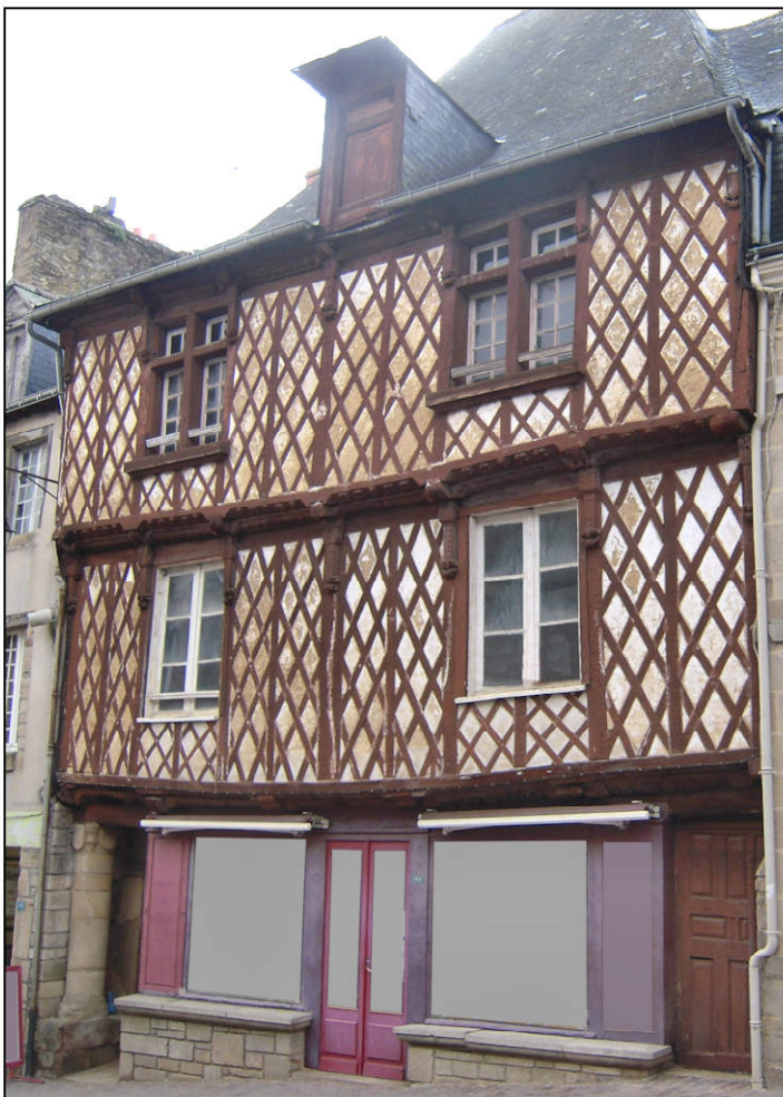
Fig. 1.3. Façade sur rue avant restauration
