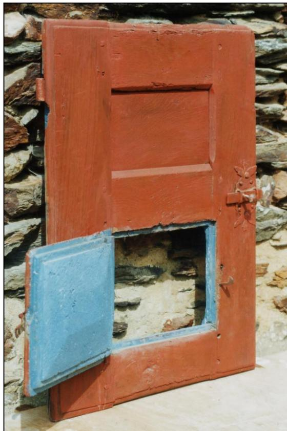
Fig. 2.5. Volet B (élévation int. / guichet ouvert)
