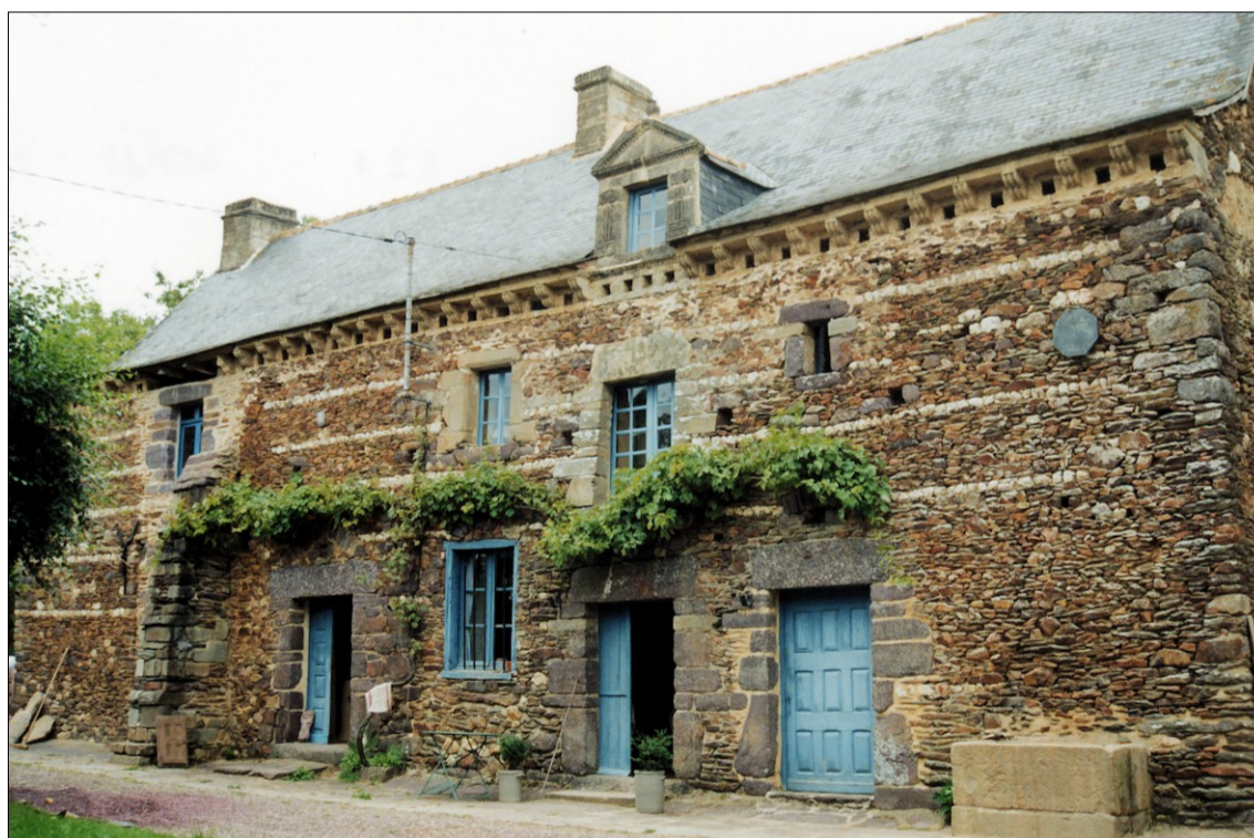
Fig. E.1. La façade antérieure
