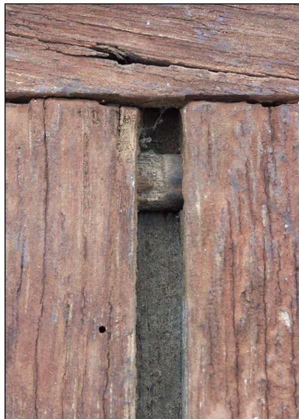
Fig. 1.4. Volet inférieur (tourillon)
