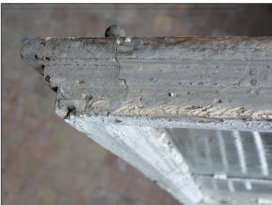
Fig. 6.6. Assemblage avec moulure flottée (vantail vitré inf.)
