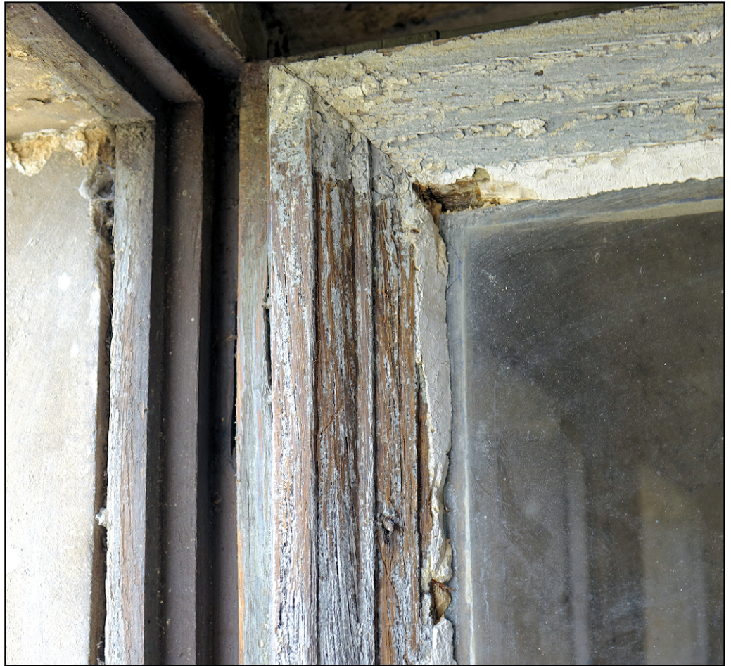
Fig. 6.2. Assemblage (vantail vitré supérieur droit)
