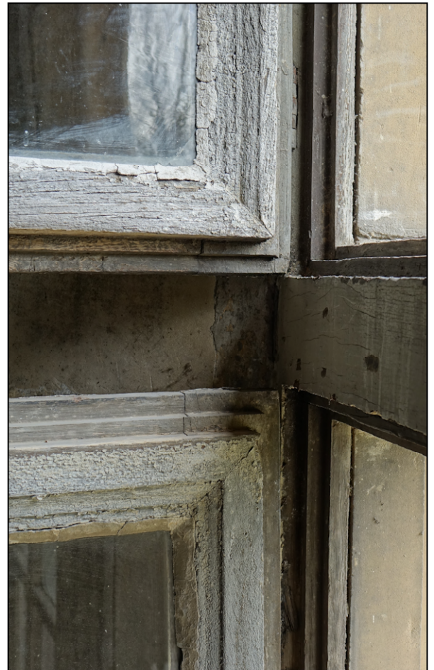
Fig. 6.5. Assemblages (vantaux vitrés gauches)
