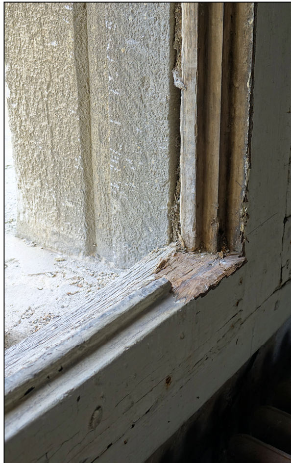
Fig. 6.4. Bâti dormant (modification de l'appui)
