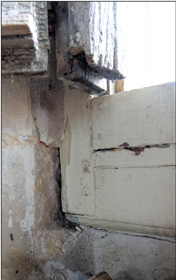
Fig. 6.3. Bâti dormant (angle inf. gauche)
