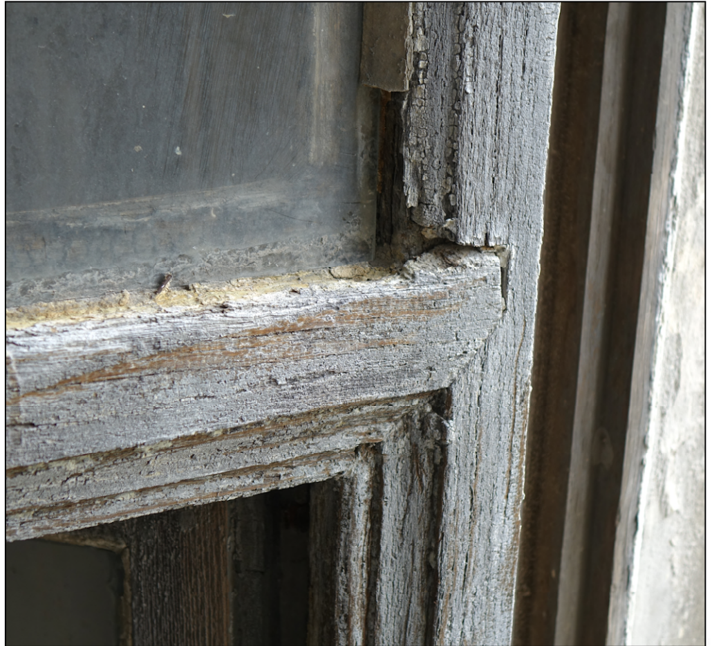
Fig. 5.3. Assemblage (traverse intermédiaire)
