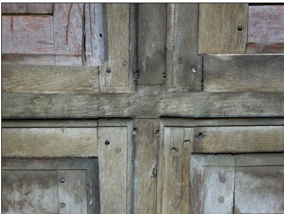
Fig. 4.4. Assemblages coincés des vantaux vitrés
