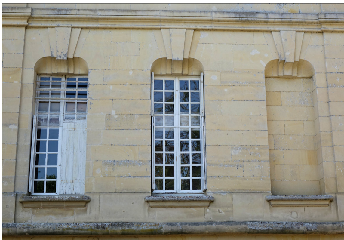
Fig. E.7. Façade nord-est. Les deux croisées d'entresol
