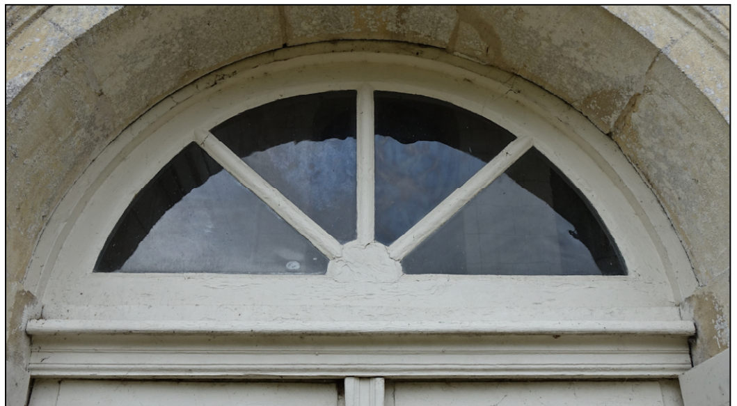
Fig. 6.4. Imposte en demi-lune (façade antérieure)
