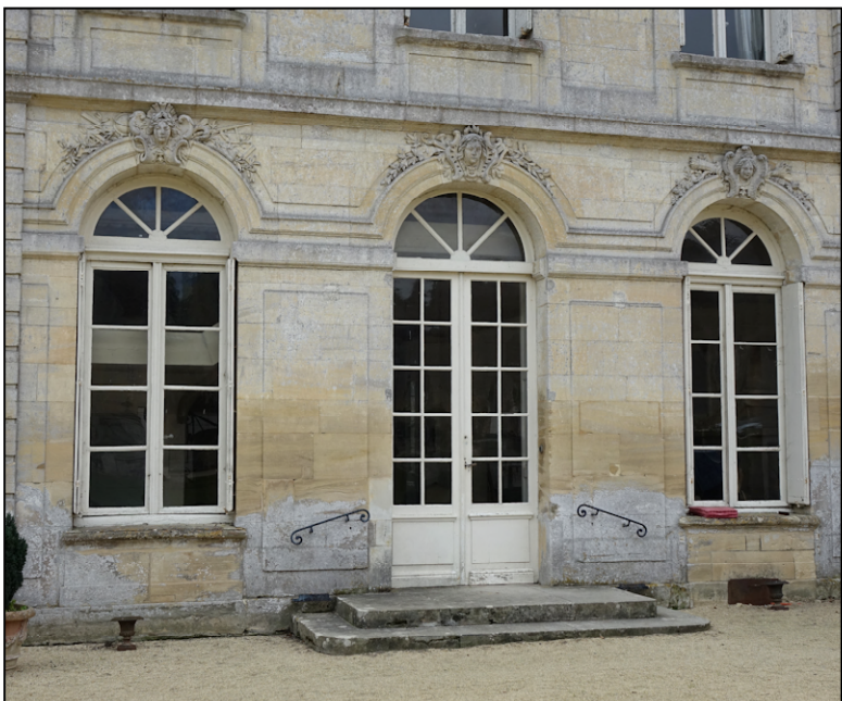
Fig. 6.5 Avant-corps central (façade antérieure)
