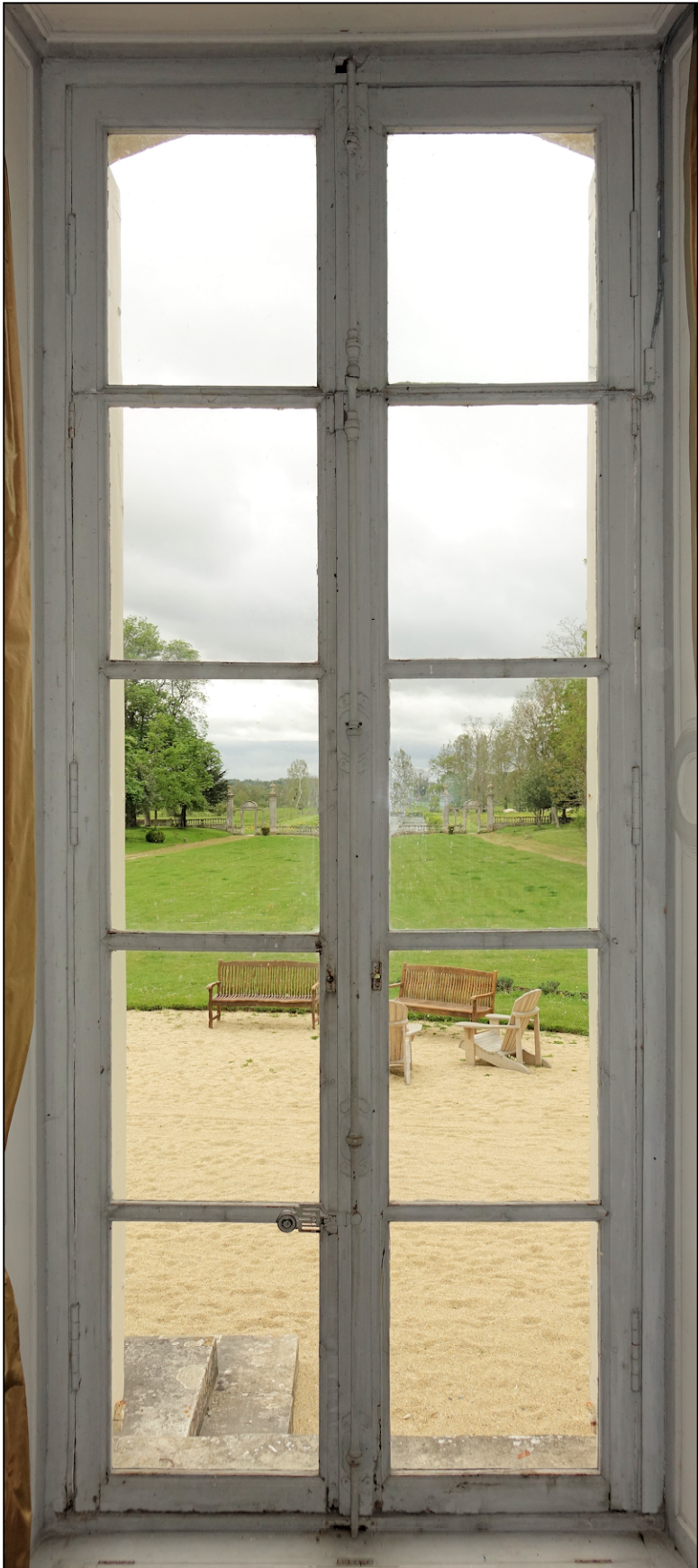
Fig. 6.1. Croisée (façade postérieure)
