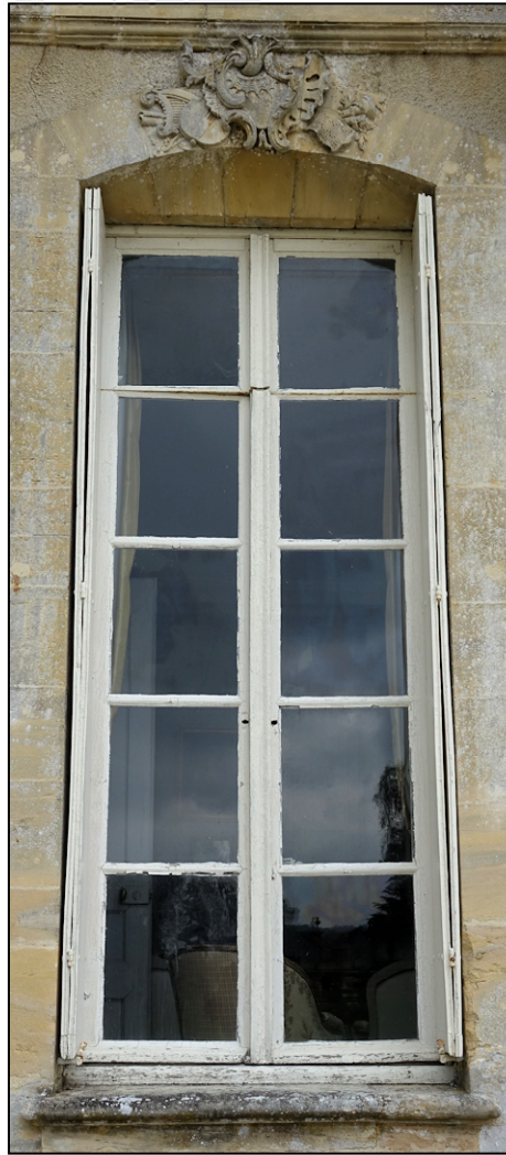
Fig. 6.2. Croisée (façade postérieure)
