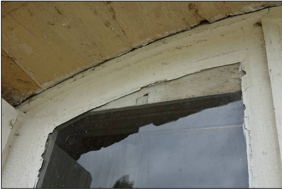
Fig. 3.1. Imposte (traverse haute)
