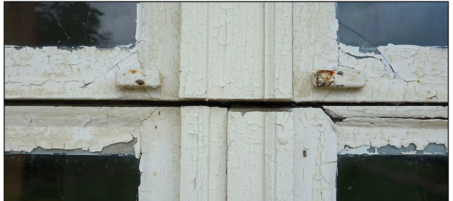
Fig. 3.5. Traverses d'imposte et des vantaux
