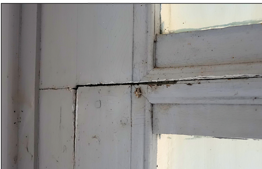
Fig. 3.4. Traverses d'imposte et du vantail
