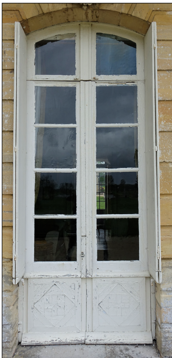
Fig. 2.2. Vue extérieure (contrevents ouverts)
